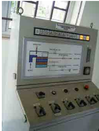
ろ過池のコントロールパネル。ろ過池の運転・清浄が行えるが、初期設定のプログラミングがうまく行われておらず、現在は手動でろ過池の洗浄を実施している浄水場がある。
