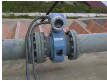
本来設置されるべき流量計(写真は設置されているシェムリアップ浄水場)
