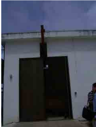
塩素ポンベがある建物 (シアヌークビル浄水場)
