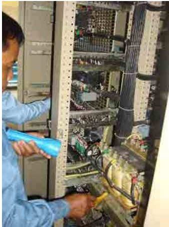
パネル内の清掃の様子
