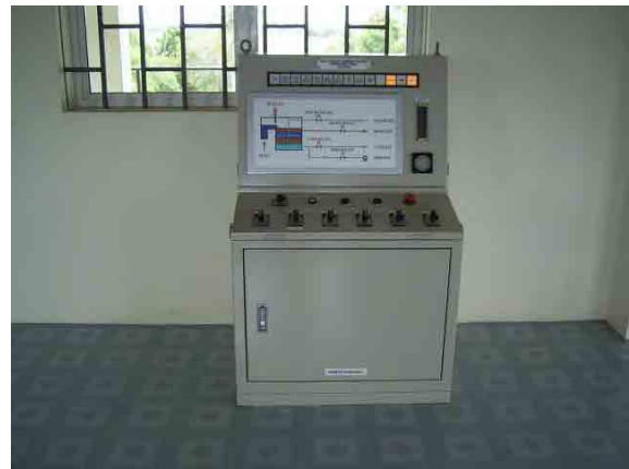
ろ過池のコントロールパネル。ろ過池の運転・清浄が行えるが、初期設定のプログラミングがうまく行われておらず、現在は手動でろ過池の洗浄を実施している浄水場がある。
