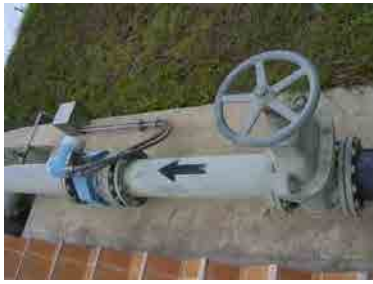
本来設置されるべき流量計(写真は設置されているシェムリアップ浄水場)
