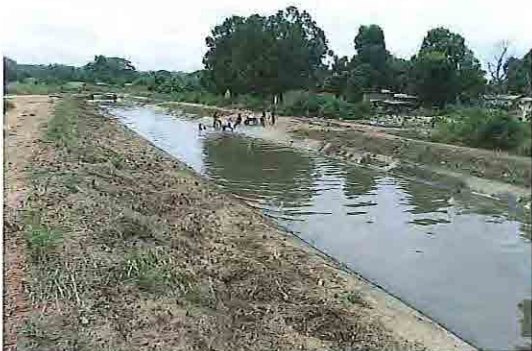
リハビリしたコンクリート・ライニング水路
