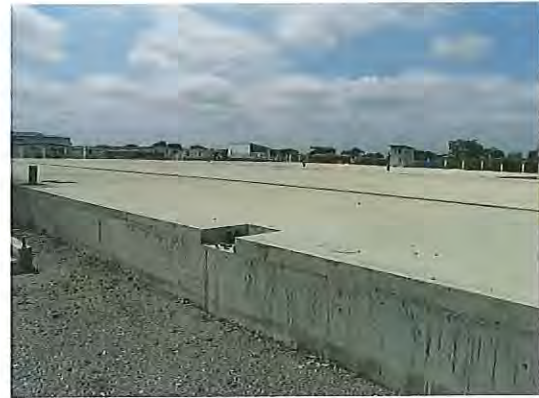
加工工場建設中（基礎部分）
