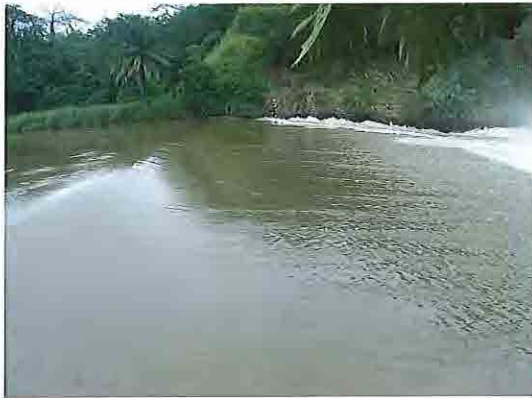
堰 河川流量が多く堰は見えない
