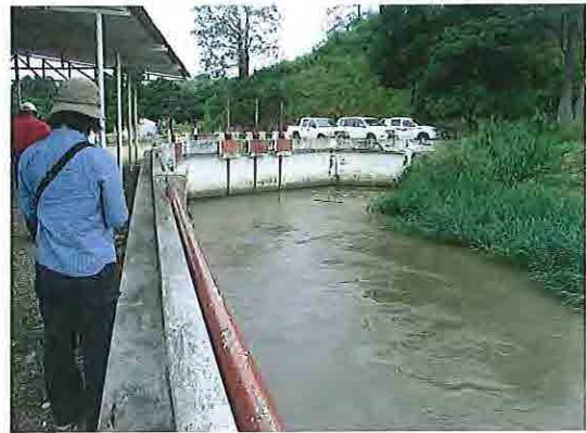
取水口 ゲートは3門ある
