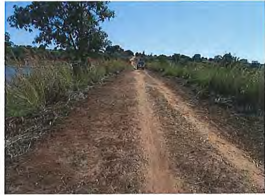
ため池の堤体
