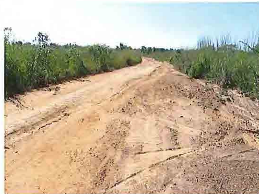
二次幹線道路 土道で凹凸が多い
