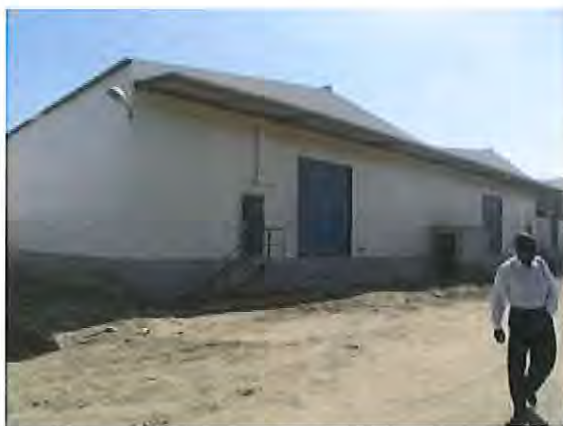
ベンゲラの冷蔵倉庫
