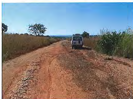
現場に来るまでの二次道路(地方主要道路)
