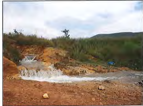
洪水吐からの流水
