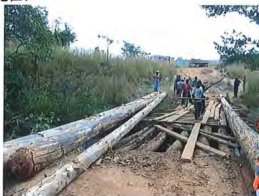
Chikava地区内の主要道、修理中の木橋
