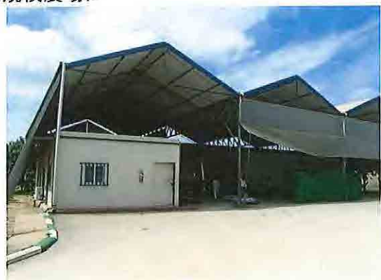
冷蔵倉庫、常温倉庫
