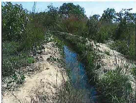
村人がつくった土水路 (水源は湧水?)
