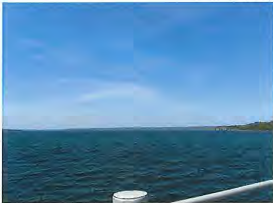
堤体からダム湖を望む
