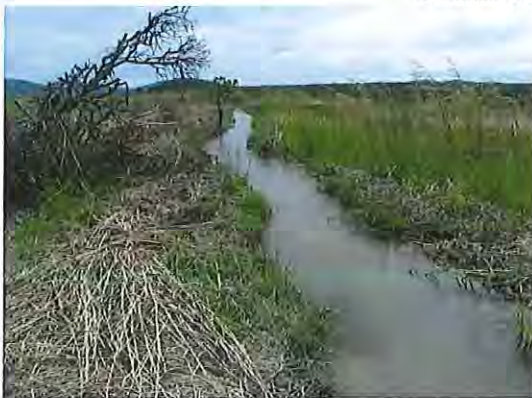
組合員で建設した土水路
