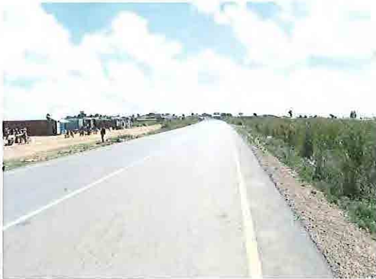
Huambo州内の幹線道路の道路 アスファルト舗装整備がされている
