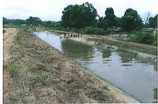
コンクリートラインニングされた幹線水路 生活用水ともなっている
