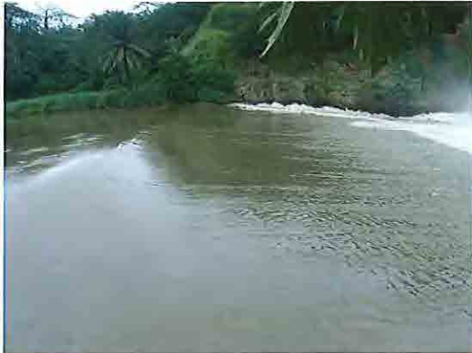
固定堰 越流のため全景が見えない
