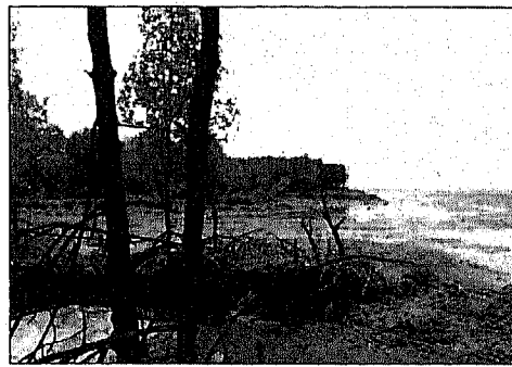
Ảnh 02 Khu vực bị xói mòn
