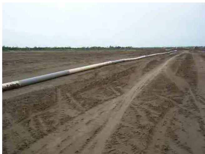
写真 3.4.5 土地造成用盛土材圧送管
