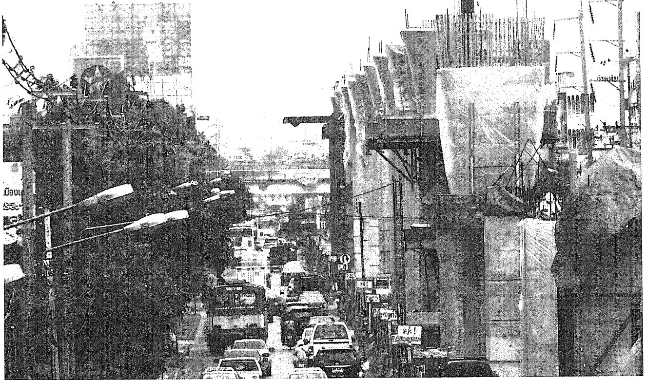
En la ciudad capital de Tailandia, Bangkok, se construye la línea púrpura del sistema ferroviario de transporte masivo, que conecta Bangkok con la provincia vecina de Nonthaburi, con los fondos provenientes del Préstamo en Yenes.
