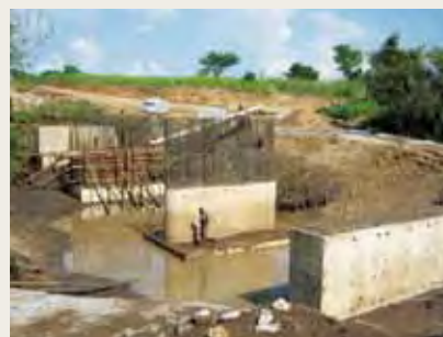
Chantier de construction du pont reliant Otwee à Anaka
