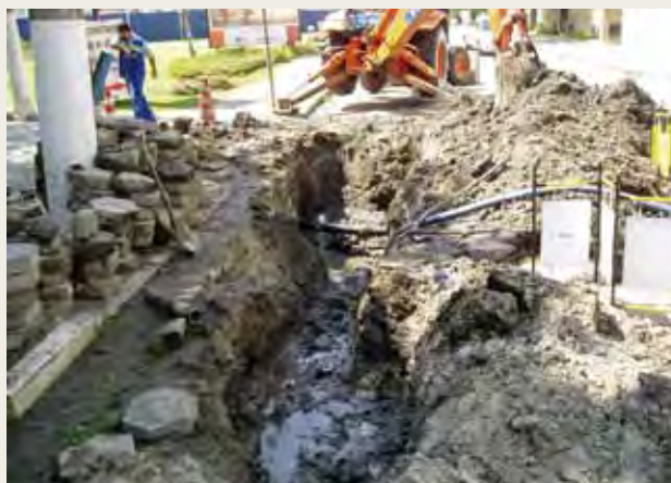
Réparation des fuites d'eau
