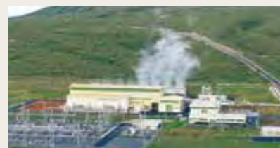
Centrale géothermique d'Olkaria II actuellement en exploitation
