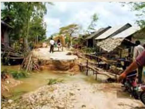
Route nationale 1 (RN 1) avant la remise en état
