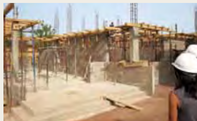
Le chantier du centre de santé avance.
