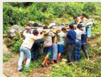
Transport d'un transformateur le long d'un chemin escarpé (électrification rurale au Bhoutan)
