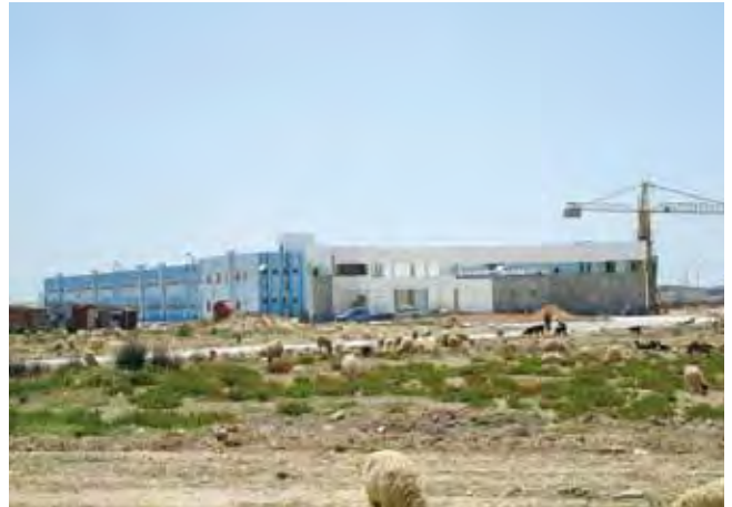
Chantier du parc technologique de Borj Cedria, à proximité de Tunis
