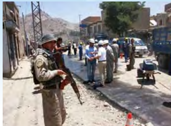
Une équipe d'experts japonais travaille à la remise en état de l'infrastructure publique.
