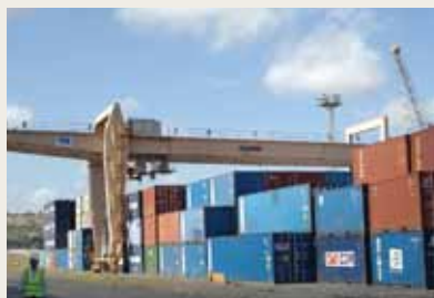
Un portique de stockage empile les conteneurs dans le port de Nacala
