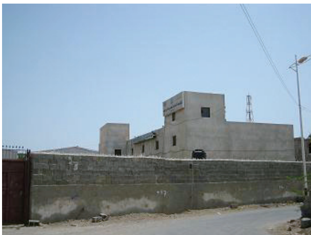
写真-11 農業サービス公社の港湾近郊の倉庫外観。2004 年度調達資機材は、荷揚げ後、この倉庫に一時保管された。<ホデイダ州>
