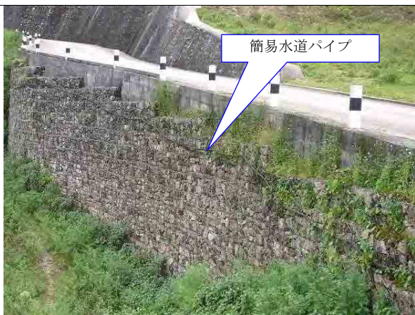
アンカー工の計画位置での水道パイプ (要移設)
