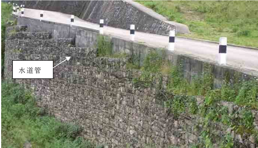
図 2.2.7 アンカー工の計画位置に設置された水道管
