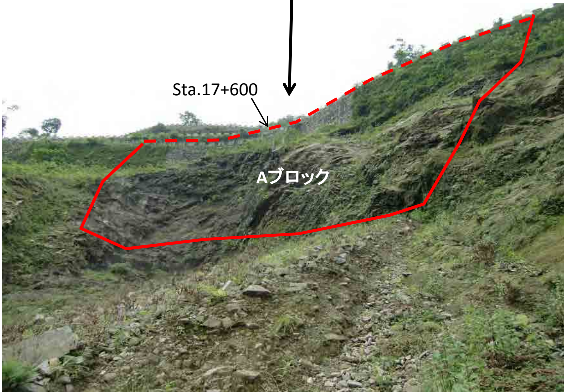
Aブロックの崩壊斜面には岩盤(石英片岩)が露出し、下方には崩壊土砂(岩塊)が堆積する。終点側の吹きつけは、DORによる応急対策工事。
