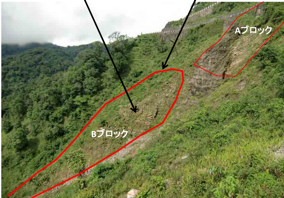
Bブロックは崩壊した沢の終点側やせ尾根地形を呈す。Bブロックは草本類や低木に被覆されている。崩壊した沢の上部はAブロック。
