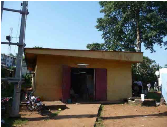
Wilberforce 変電所の様子
