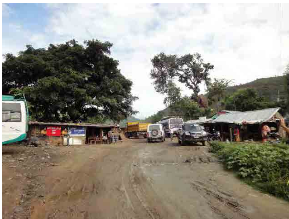
Sta.39+320 付近クルコット地区
