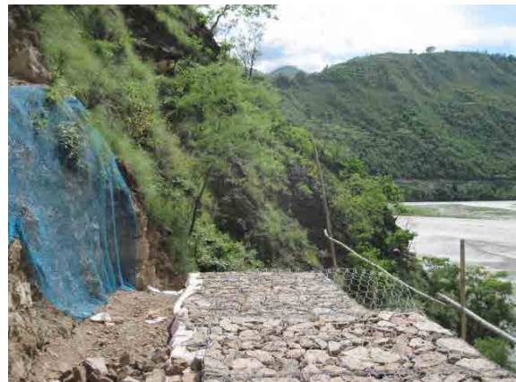
Sta.26+500 付近 1/2期との接続部
