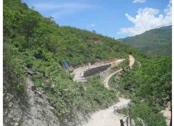
Sta. 15+500 付近のムルコット地区
