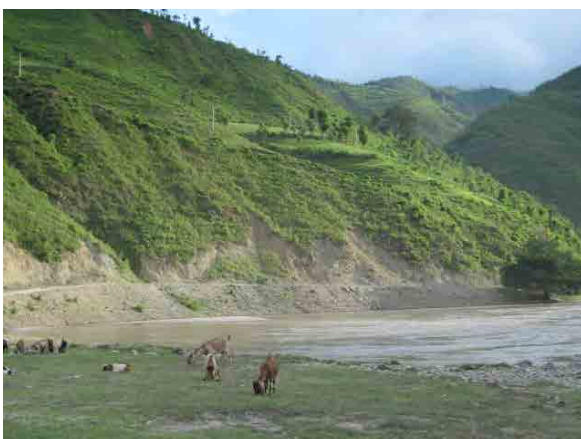
Sta.10+500 付近の斜面
