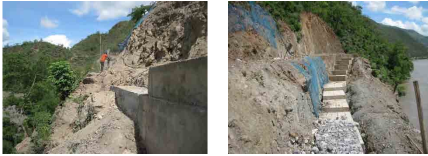
図 2-8 地形・支持地盤を確認しながら擁壁工事をしている例 (左:第三工区(1/2期)STA.27 付近、右:同 STA.1 付近)
