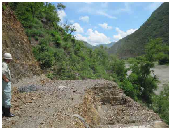
Sta.2+300 付近 1/2 期との接続部
