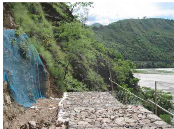
Sta.26+500 付近 1/2期との接続部
