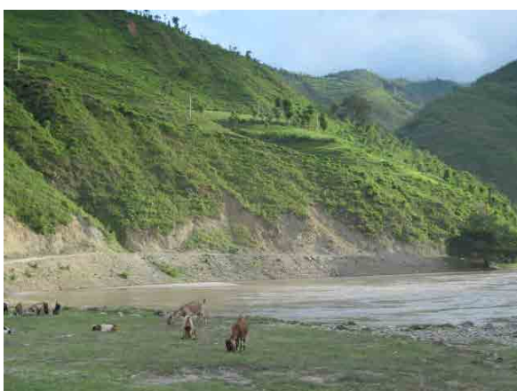
Sta.10+500 付近の斜面
