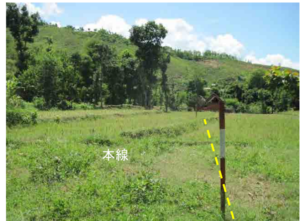
Sta.21 付近 ボレタル地区(2/2期前段)
