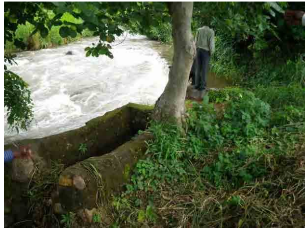
モロンゴチ灌漑区域の取水口 (撮影日：2011年3月18日)
