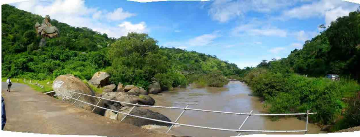
South Rukuru 川の橋梁から上流側を見る（撮影日：2011年3月18日）
