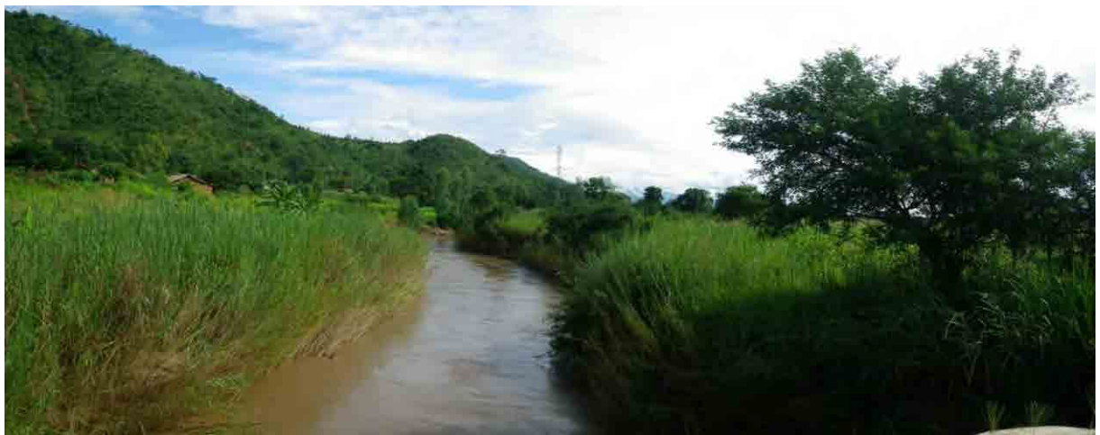
Kasitu 川に架かる橋梁から下流を見る (撮影日 : 2011 年 3 月 18 日)
