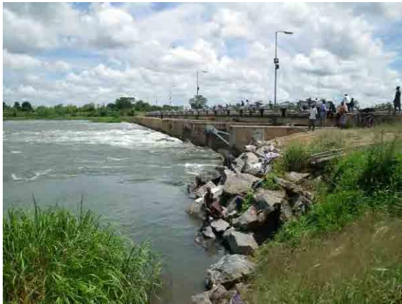
マラウイ湖の水位を調節するために 1965 年に Shire (シレ) 川に設置された Liwonde (リウオンデ) 堰 (撮影日 : 2011 年 3 月 5 日)
