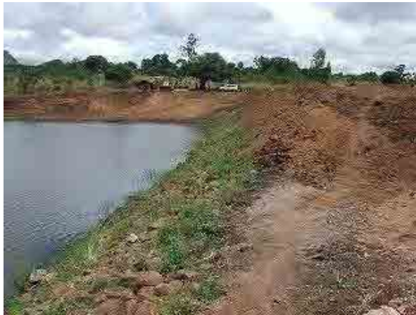
Chimvu Dam & Irrigation Scheme、現在補修中。1970年代築造。2011年3月現在、MoIWDのISDによって補修中。ダム高=約8m、長さ=100m、堤体材料=土、洪水吐き=不明、ISDが組合設立作業中 (撮影日：2011年3月9日)
