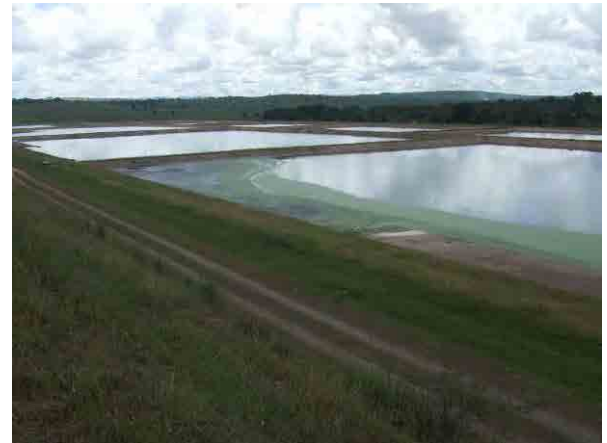
リロングウェの下水処理場 (撮影日：2011年3月22日)
