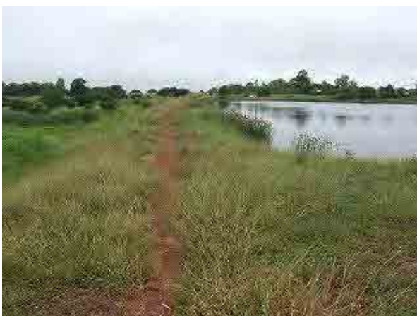
Chileka Dam & Irrigation Scheme の灌漑成功例。1970年代築造。ダム高=約5m, 長さ=80m, 堤体材料=土, 洪水吐き=石とコンクリート, 灌漑面積=8 ha, 農民数=50（撮影日：2011年3月9日）
