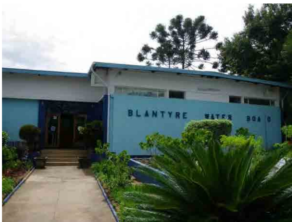
Mudi ダムのそばにある Blantyre Water Board の本部 (撮影日 : 2011 年 3 月 7 日)
