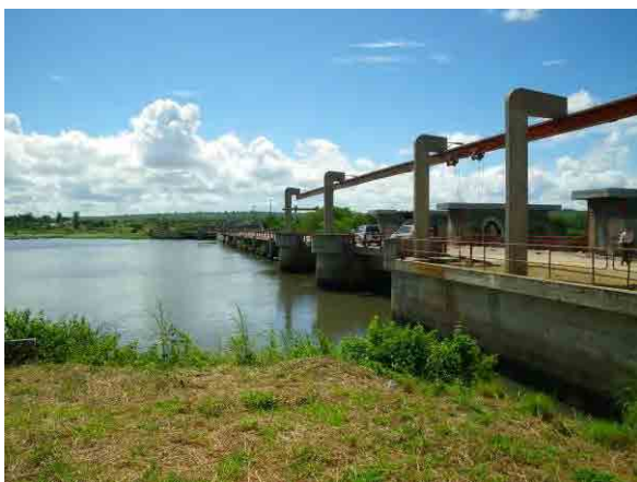
Shire 川の発電用の Nkula (ヌクラ) ダム (ESCOM 管理) を上流側より見る (撮影日 : 2011 年 3 月 6 日)
