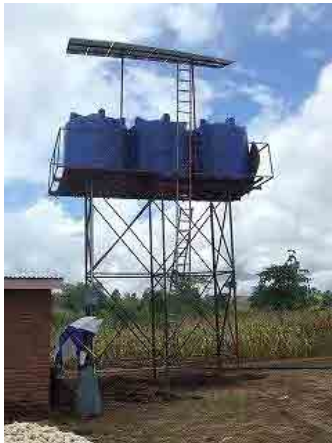
Makamde Irrigation Scheme。NGOによる太陽光発電を利用した灌漑施設のリハビリ。ディーゼルポンプを小川に設置して灌漑利用していたものを、太陽光発電を利用したポンプで高架水槽に汲み上げ、灌漑利用するようにリハビリする事業が現在施工中。NGOのLard (Relief and Development) がISDと共同で実施。 (撮影日：2011年3月9日)
