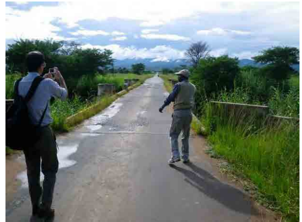
ルンピ近くで Kasitu 川に架かる橋梁 (撮影日 : 2011 年 3 月 18 日)
