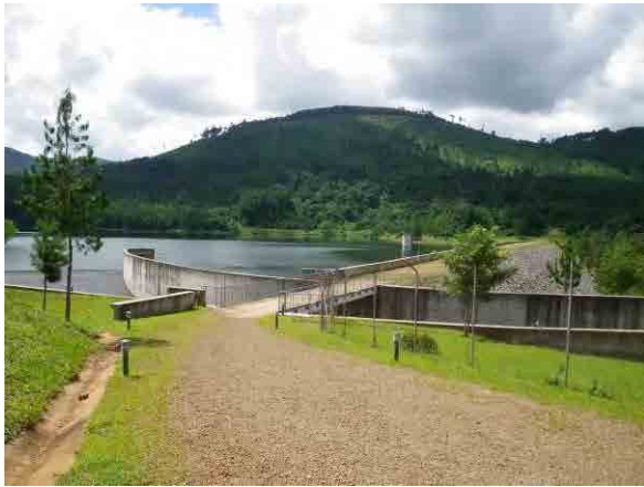
2001 年 5 月に NWDPI の南部地域水公社ゾンバ水供給プロジェクトによって築造された Mulunguzi (ムルングジ) ダム (撮影日 : 2011 年 3 月 5 日)
