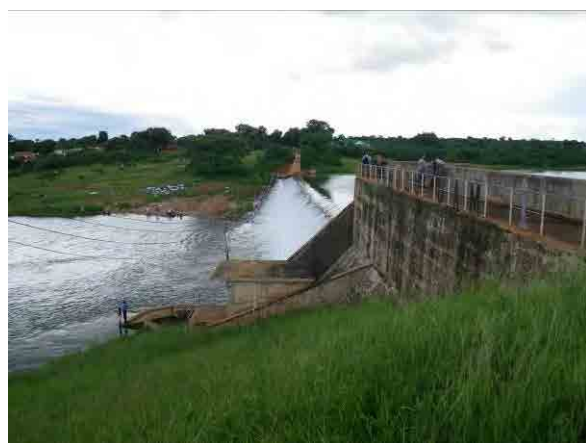
Mzuzu (ムズズ) ダム I (撮影日: 2011 年 3 月 3 日)
