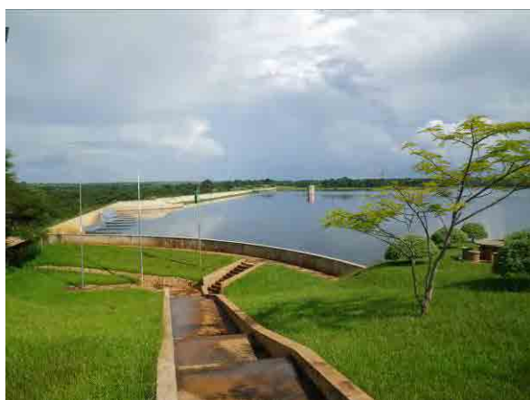
Mzuzu(ムズズ)ダム II (撮影日: 2011 年 3 月 3 日)
