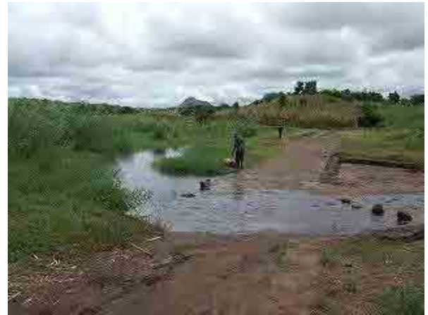
Chisoka Dam & Irrigation Scheme、ダム湖が土砂で堆積して貯水機能がなくなってしまったダム。1970年代築造。ダム高=約4m、長さ=100m、堤体材料=土、洪水吐き=不明 (撮影日：2011年3月9日)
