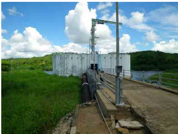
Blantyre Water Board (ブランタイヤ水公社) の Walker's Ferry (ウォーカーズフェリー) 取水・浄水・ポンプ場の取水施設 (撮影日: 2011年3月6日)
