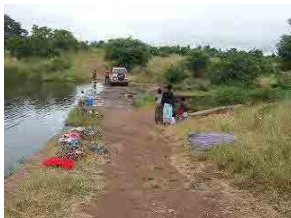
Milala Dam & Irrigation Scheme の灌漑成功例。1970年代築造。ダム高=約3m, 長さ=80m, 堤体材料=土, 洪水吐き=レンガ, 灌漑面積=6 ha, 農民数=36（撮影日：2011年3月9日）
