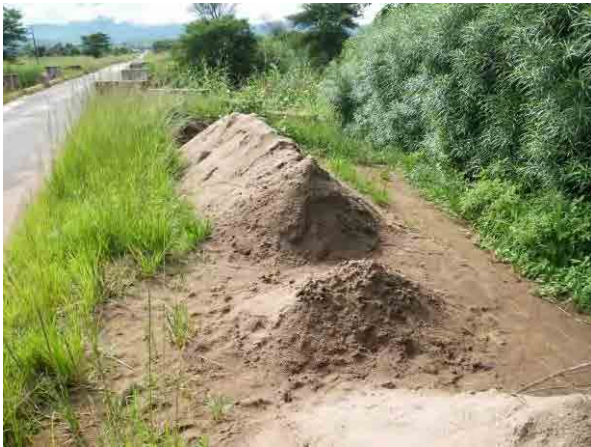
掘削された Kasitu 川に堆積した土砂 (撮影日：2011年3月18日)
