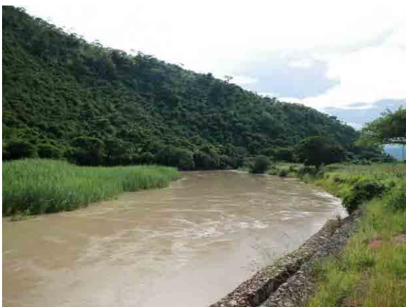
South Rukuru 川同上地点から下流側を見る。道路局によって道路保護のため右岸側に蛇籠護岸が設置されている (撮影日：2011年3月18日)
