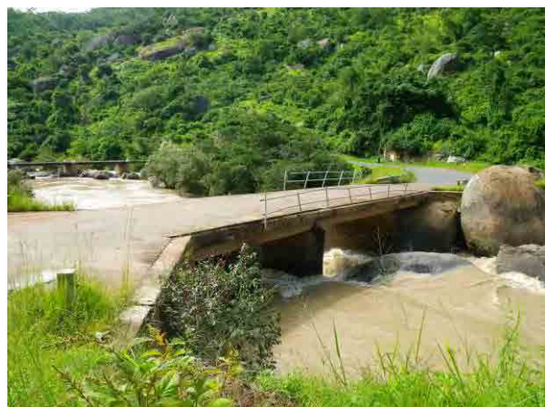
South Rukuru 川ルンピから下流側の狭窄部に架けられた橋梁。左岸側から下流を見る (撮影日：2011年3月18日)
