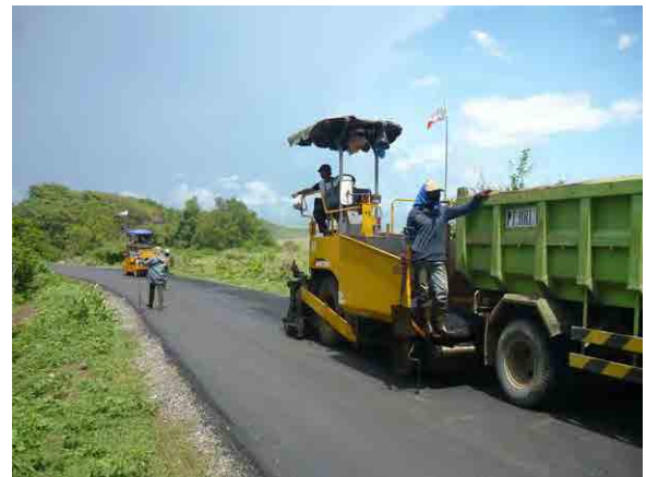
対象道路の改修実施状況（Sta. 43km付近）
