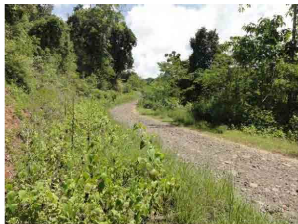
対象道路の急勾配区間（Sta. 18km付近）
