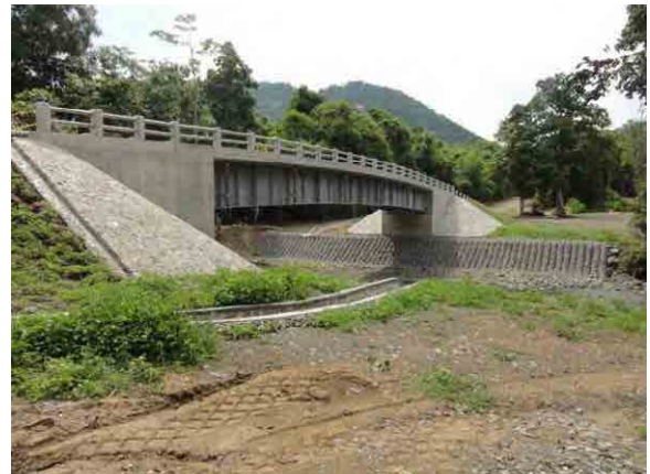
我が国協力（第二次）で建設された橋梁（BR-3）
