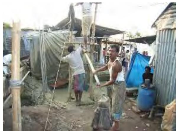
ラボ前での井戸掘削状況：手掘り方式
