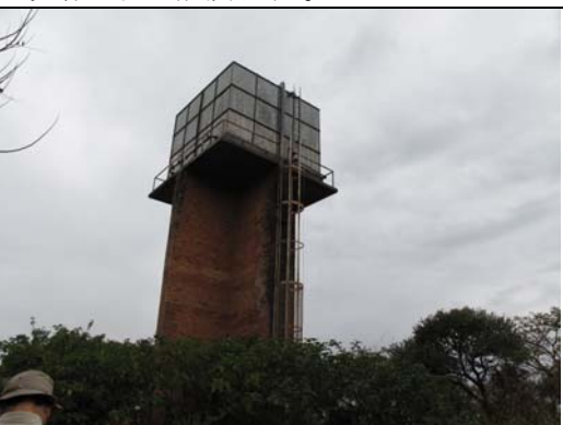
写真-6：ナミテテ・チレカ地区マーケットセンターに隣接する中学校の水道施設（高架タンク）。近傍で3本の試掘を行ったが揚水量は大きく需要を下回った。
