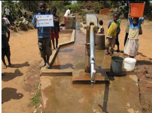
写真-7：我が国の無償資金協力「ムチンジ地下水開発計画」(1992-1995)により建設されたハンドポンプ付き井戸。全300本のうち現在約7割が稼動している。
