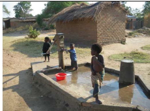
写真-1：ムカンダ地区マーケットセンター内の既存水源。我が国の無償資金協力「ムチンジ地下水開発計画」(1992-1995)で建設された井戸。
