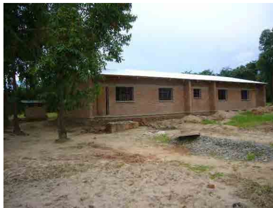
建設中の実験棟 (USAIDによる供与 2011年完成予定)
