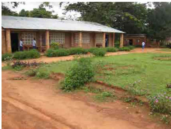
1998年建築の既存2教室棟外観
