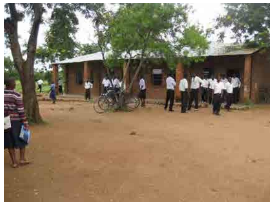
1993年に建設の既存4教室のうちの1棟2教室外観
