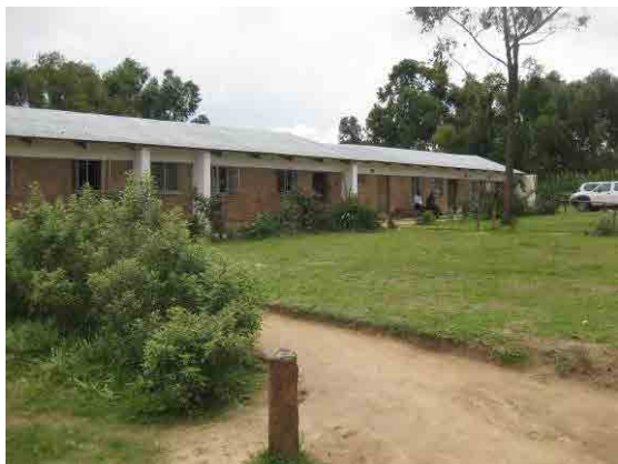
アクセス道路からの教室棟 2005年コミュニティ建設
