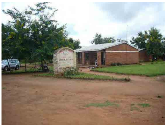
2003年に建設の管理棟 (教室に転用を予定する)
