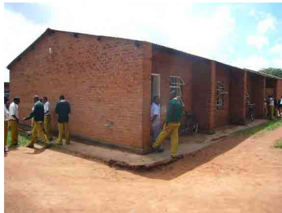
既存4教室教のうち2008年に増設された2教室外観
