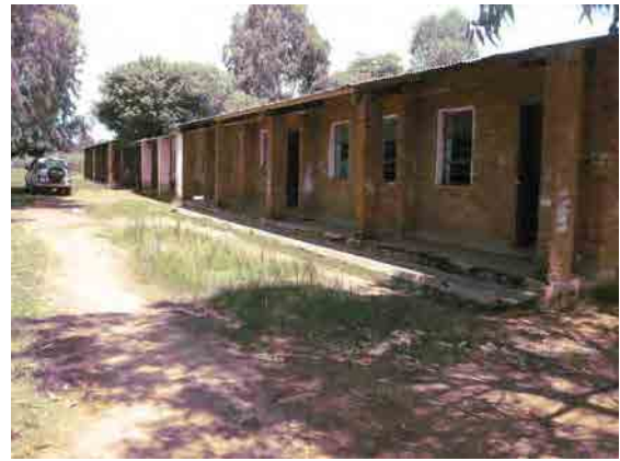
2000年に建設の既存4教室外観
