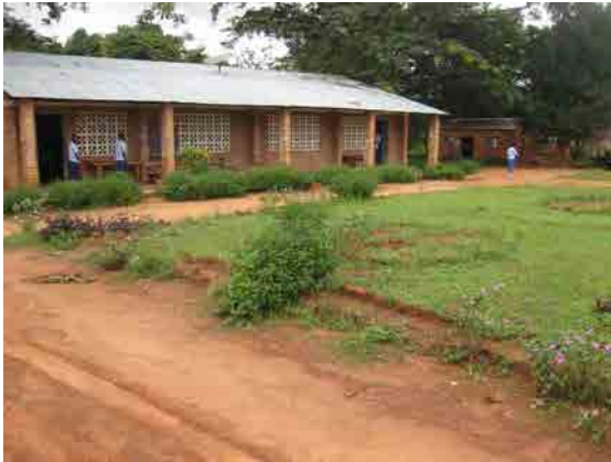
1998年建築の既存2教室棟外観
