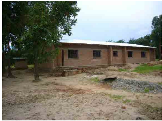
建設中の実験棟 (USAIDによる供与 2011年完成予定)
