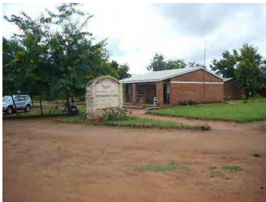
2003年に建設の管理棟 (教室に転用を予定する)
