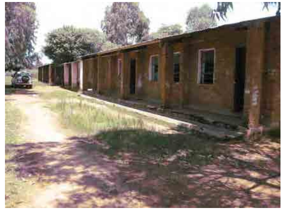
2000年に建設の既存4教室外観
