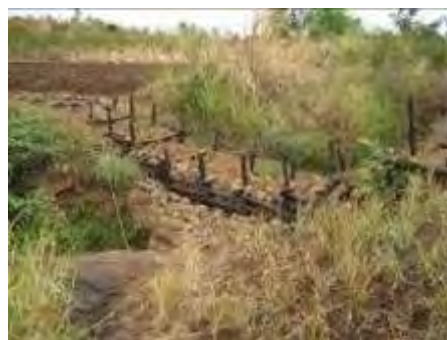
土壌浸食対策（中規模チェックダム）
