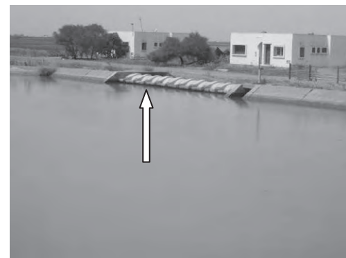
写-16 低位部幹線水路余水吐 (上部は管理棟及び倉庫)
