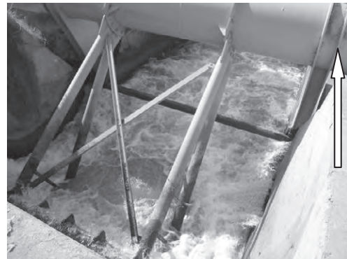
写-36 左に同じ(水衝部は一部塗装がはげているが管理状況は良好)
