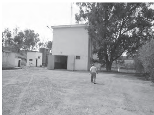
写-21 Bir Abid ポンプ場 (建屋)
