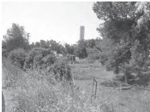
写-4 スプリンクラー灌漑用高架水槽 (幹線水路より取水)
