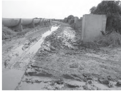
写-30 付替え後の2次水路内部
