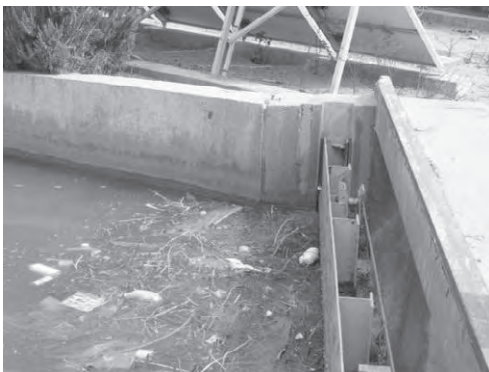
写-37 高位部幹線水路 (II 期地区)末端部角落し
