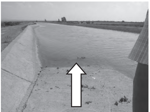
写-32 幹線水路斜路 (工所用あるいは維持管理用車両の搬路)
