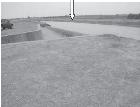
写-7 低位部幹線水路余水吐 (横越流式)
