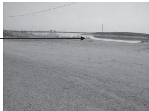
写-8 低位部幹線水路調整池
