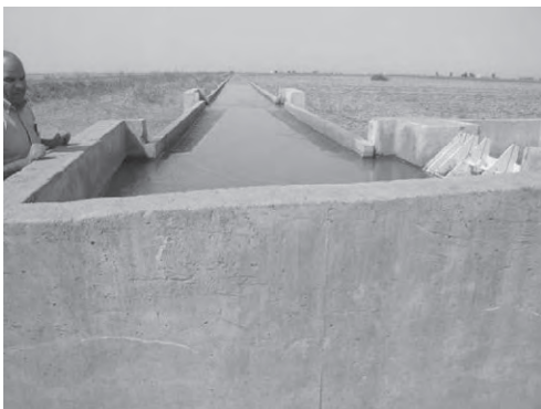
写-14 2次水路及び分岐工
