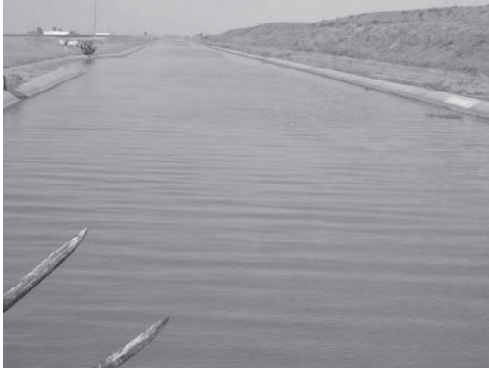
写-33 高位部幹線水路 (II 期地区)末端部
