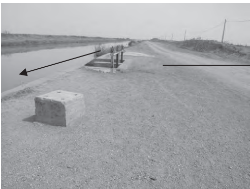
写-7 低位部幹線水路調整池取水口
