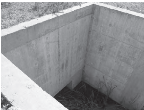
写-39 幹線水路横断カルバート
