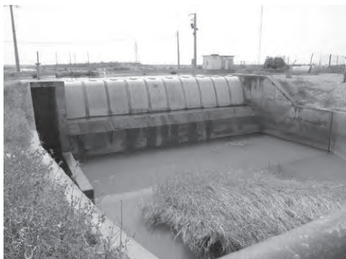
写-17 低位部幹線水路余水吐ゲート (下流側)
