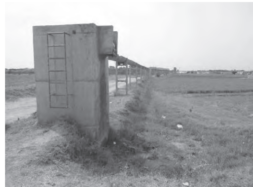
写-24 2次水路サイホン吐口
