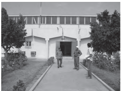
写-8 高位部ポンプ場建屋
