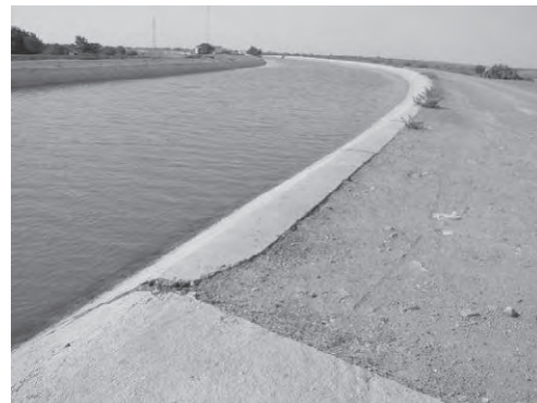
写-31 幹線水路湾曲部
