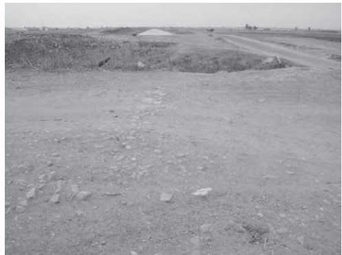
写-12 低位部幹線水路サイホン部 (この谷が排水路となる)
