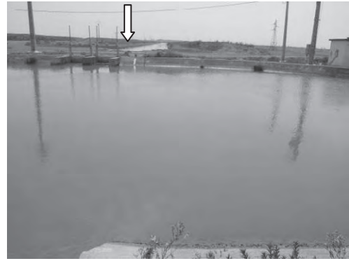
写-10 Bir Abid ポンプ場への導水路
