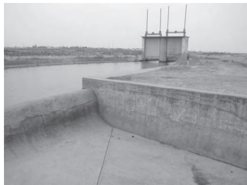
写-8 余水吐及び幹線水路開閉ゲート
