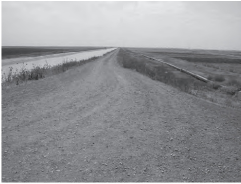
写-25 高位部幹線水路(II期地区)及び管理用道路
