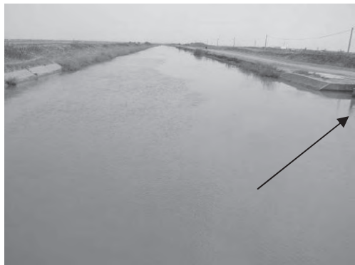
写-6 低位部幹線水路調整池取水口
