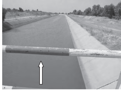
写-18 写-17 地点の下流側
