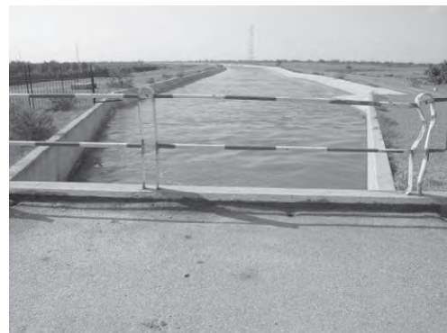
写-38 水位調整堰下流側幹線水路
