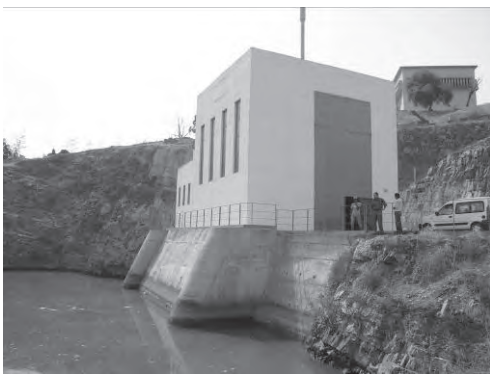
写-3 高位部導水トンネル取水口前面及びゲート室
