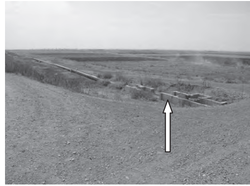
写-26 高位部幹線水路脇の下位水路及び分水
