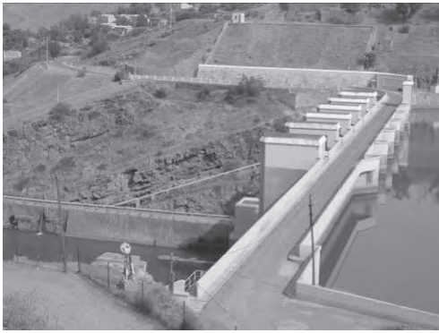
写-1 Imfout ダム堤頂及び洪水吐
