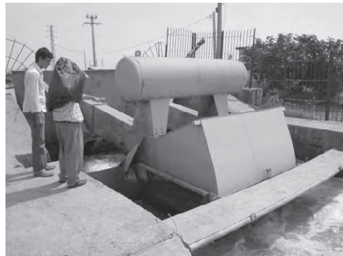
写-14 左に同じ (下流側)
