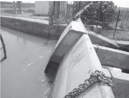
写-13 ゲートの状況 (上流側)
