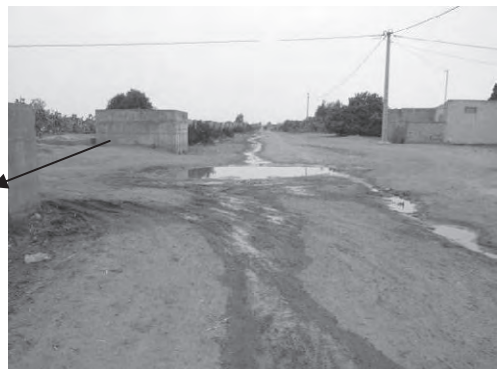
写-18 左に同じ (1次水路からの漏水)
