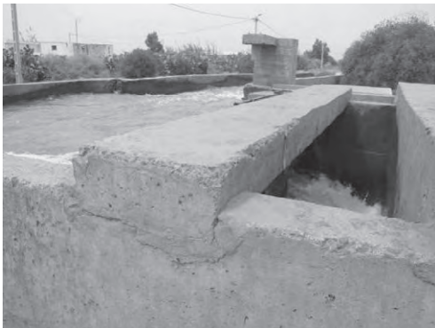
写-15 低位部水路サイホン吐口 (分土工)
