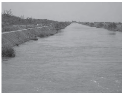
写-20 左に同じ (コンクリート・ ライニングと土水路の分岐)
