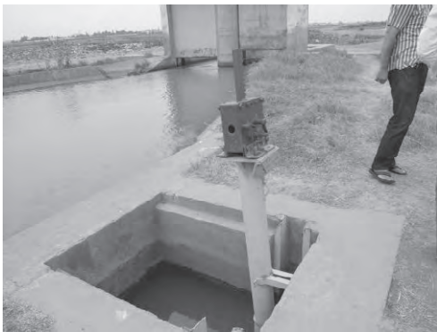
写-9 余水吐直下流の排水ゲート
