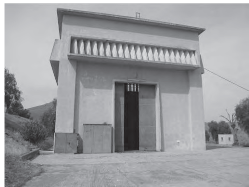
写-4 低位部導水トンネル取水口ゲート室
