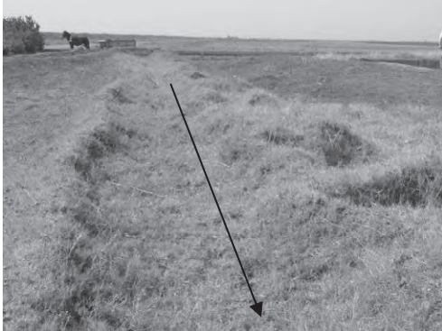
写-10 4次水路 (土水路)
