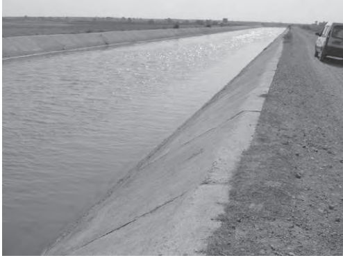
写-25 高位部幹線水路
