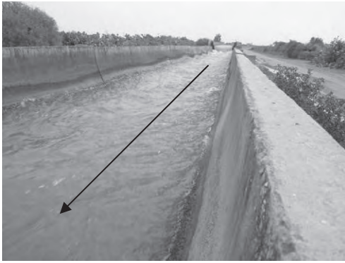
写-21 1次水路(半割フリューム管)の内部
