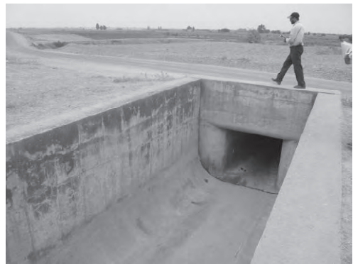
写-10 排水ゲートに続く排水路 (余水吐と合流)
