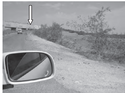
写-16 高位部幹線水路始点直下流の 高架水路
