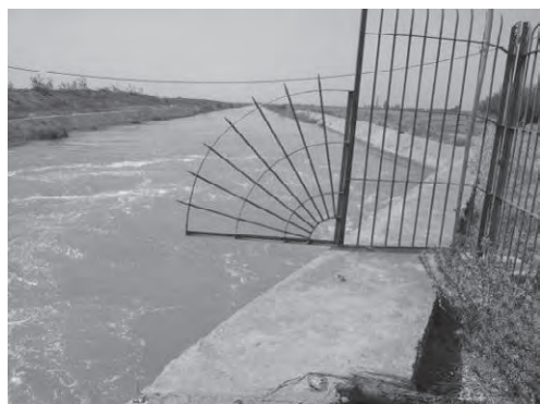
写-19 水位調整堰下流
