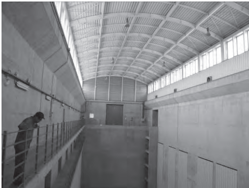
写-11 ポンプ場建屋内部上部
