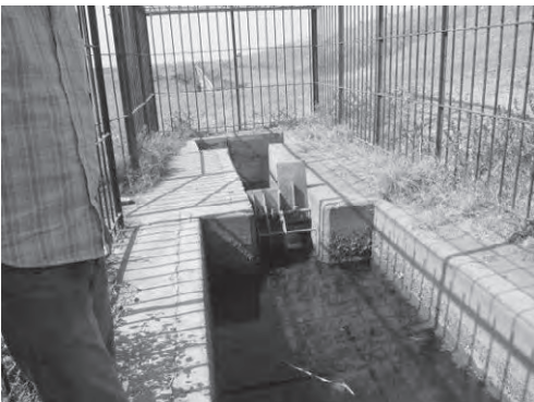
写-23 分水工及び2次水路
