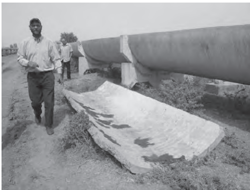
写-27 付替え後の2次水路 (旧管に残る水草)
