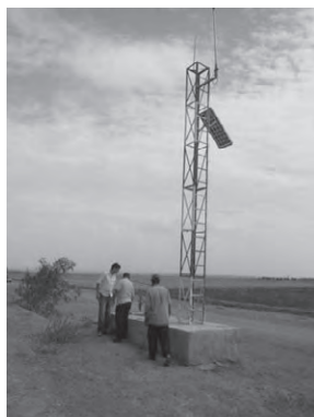
写-31 水位データ送信塔(ソーラーパネル付き)
