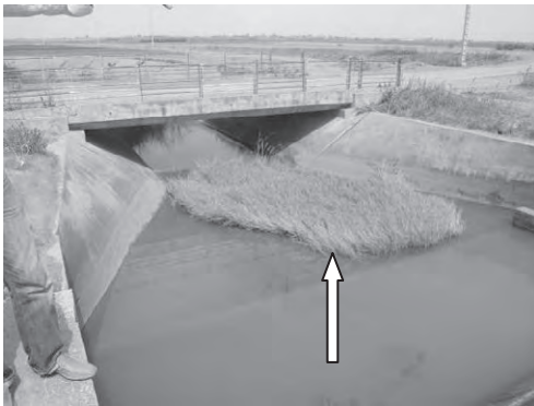
写-11 低位部幹線水路内の植生 (水路橋下流側拡幅部)
