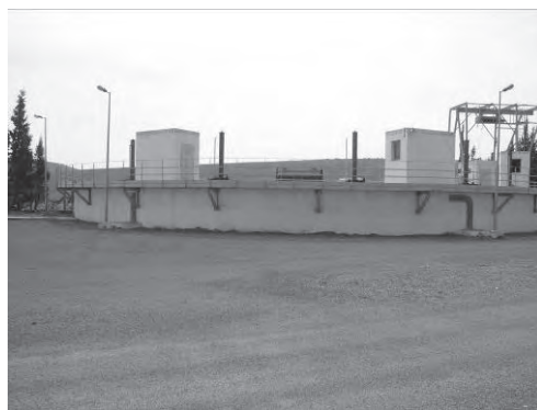
写-7 高位部ポンプ場受水槽
