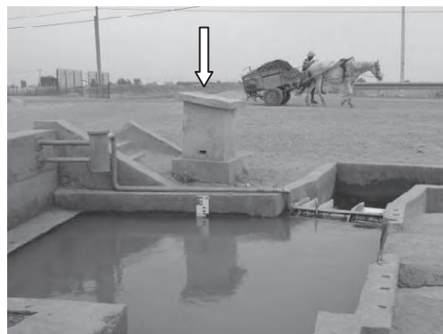
写-4 分土工水位計測管及びパソコン格納箱 (現在は廃棄)
