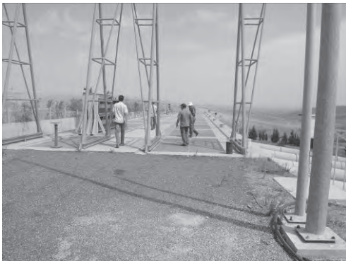
写-13 吐水槽 (高位部幹線水路始点)
