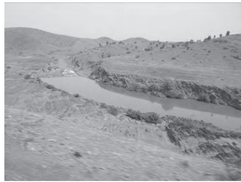
写-6 ダム下流側 Oum Er Rbia 川の状況
