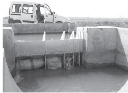
写-17 分岐ゲート背面 (土嚢、ビニールシート、枝等で止水)
