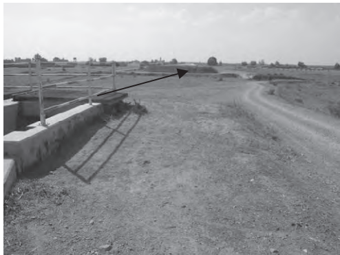
写-27 サイホン横断部 (毎年、サイホンの底浚いを実施)
