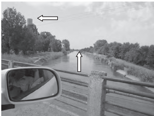
写-3 低位部幹線水路 (Aounate 付近) 及び高架水槽 (写真左奥)
