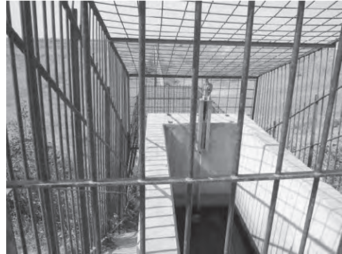
写-20 盗難防止防護柵で囲まれた 分水工カルバート開口部端部
