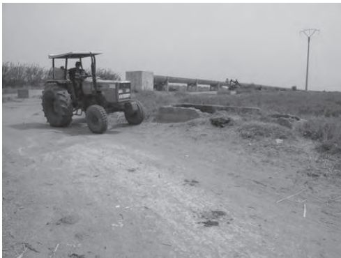
写-23 2次水路(半割フリューム管) 及びサイホン部
