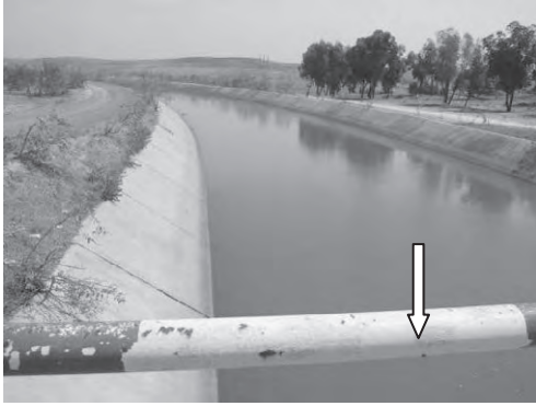
写-17 高位部幹線水路始点直下流水路橋の上流側
