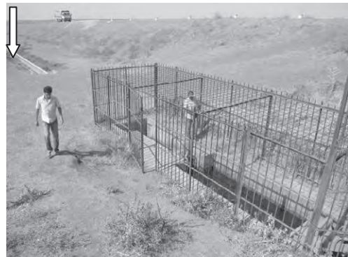
写-22 盗難防止防護柵で囲まれた分水工 及び2次水路
