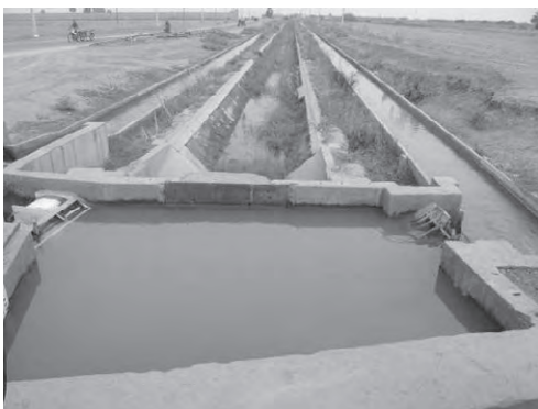
写-3 低位部幹線水路分土工及び下位水路 (中央部は旧水路)
