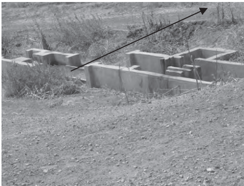
写-27 下位水路分土工
