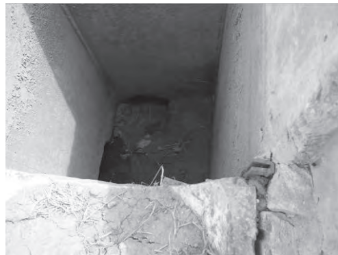
写-32 サイホン吐口及び止水板替りの泥
