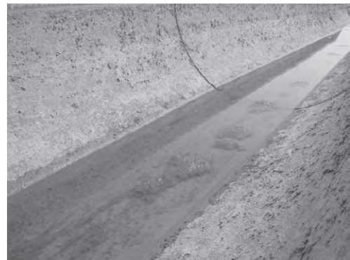
写-28 付替え後の2次水路内部 (水草が底に付着)
