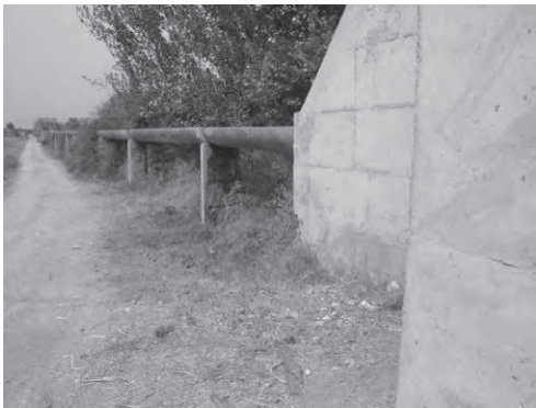
写-25 3次水路 (半割フリューム管) 高架部
