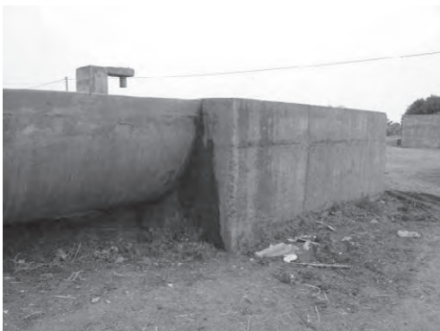
写-17 低位部水路サイホン部
