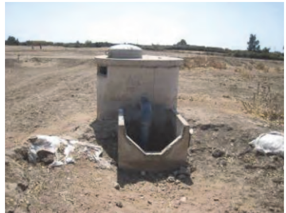
分水工 3次水路 (パイプライン) → 4次水路 (土水路)
