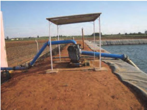
加圧ポンプ ( Q=75\text{m}^3/\text{h} )
