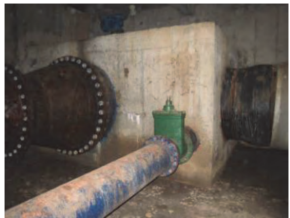
分水工 幹線： \phi = 1,200\text{mm} 、支線： \phi = 1,000\text{mm}
