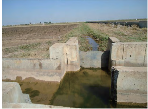
3次用水路から4次水路（土水路）への分水
