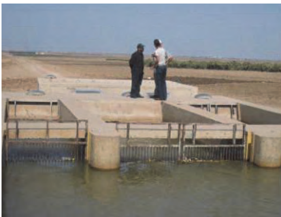
パイプライン流入口
