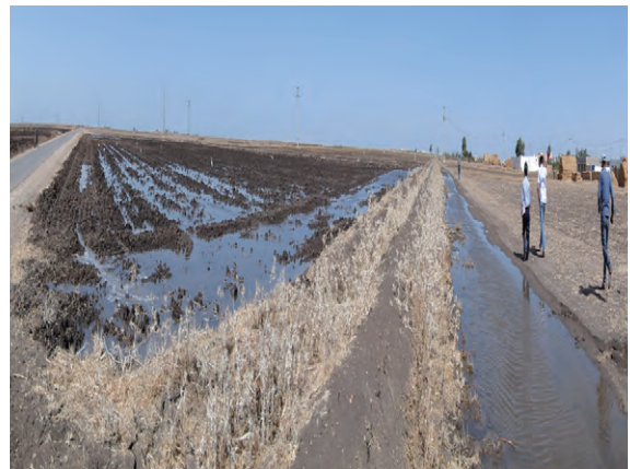
圃場反対側への漏水
