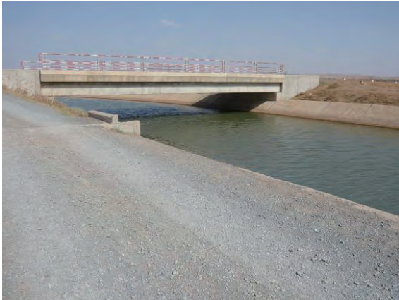
高位部幹線水路分水口 (カルバートで管理用道路横断)
