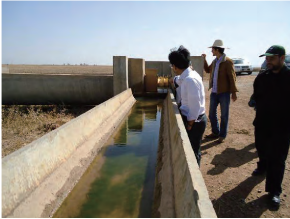
3次用水路（低位部、コンクリート水路）
