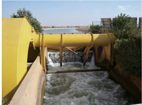
幹線水路水位調整ゲート
