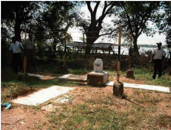
対空標識設置
