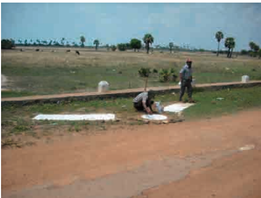
写真 3-2 対空標識設置
