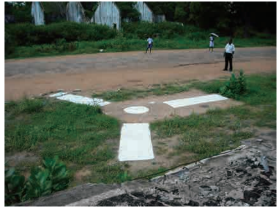
対空標識設置
