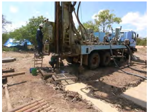
井戸掘削中の DDCA 井戸建設チーム
