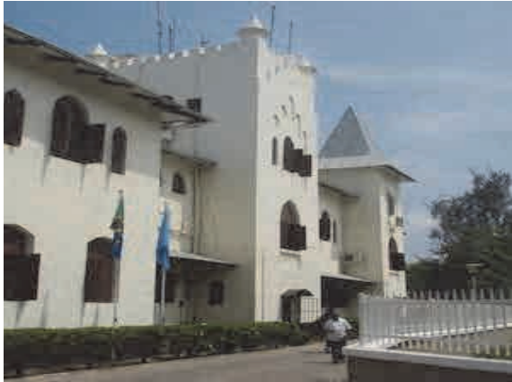
1 階に NACP/プロジェクト事務所のある建物。2 階は WHO 事務所
