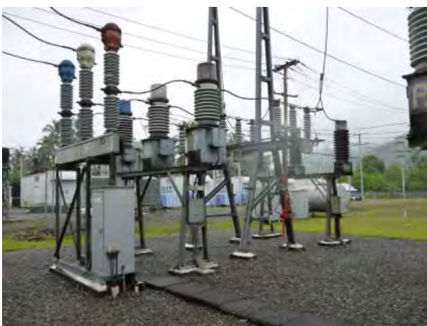
66 kV Switchgear
