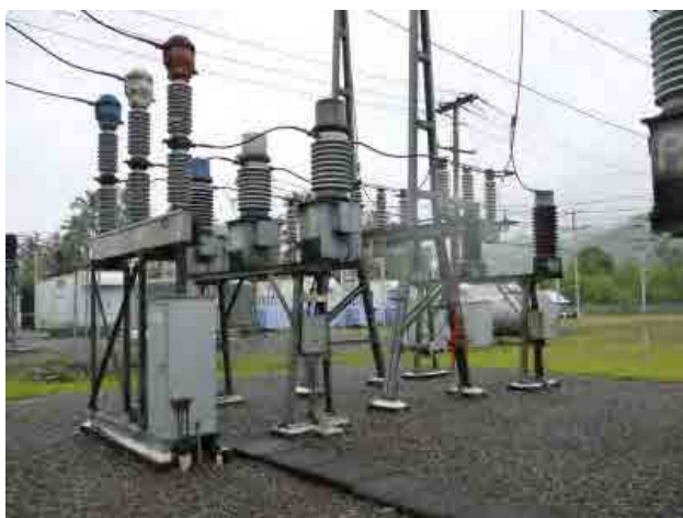
66 kV Switchgear
