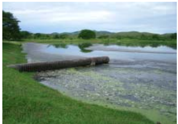
Waigani処理場の処理池への流入パイプ
