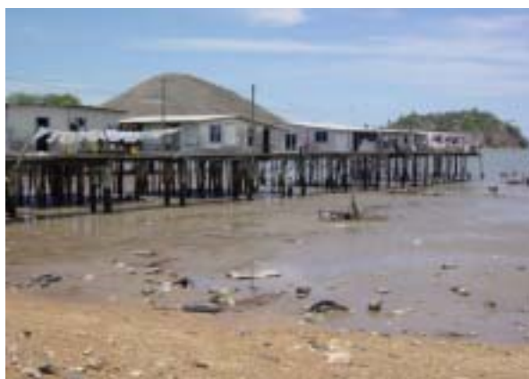
Badiliの放流管状況
