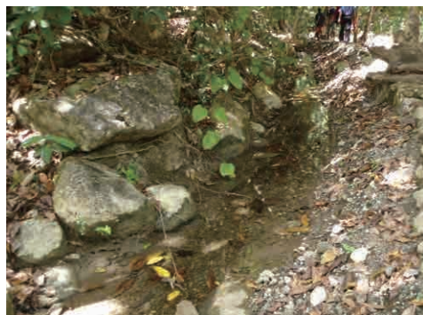
ダルダウ灌漑地区 現況水路 (写真は取水工直下流の水路であるが、ライニングは実施されていないため、浸透ロスが大きい)
