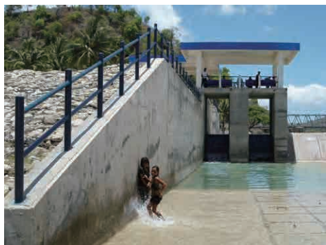
ベブイ灌漑取水工 (写真は土砂吐下流)
