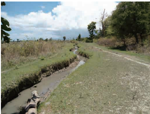
既存灌漑水路
