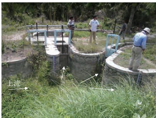
カラウルン灌漑分水工 (最上流の幹線と2次水路の分水)
