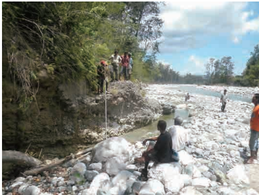
既存取水口（左岸）
