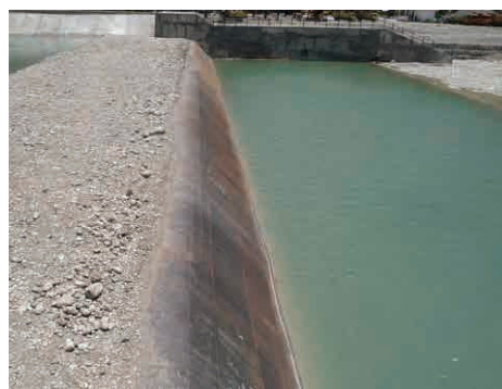
固定堰 (特徴は堰下流面保護に鋼板を採用したことである。保護工法は施設の耐用年数により選定される問題である)
