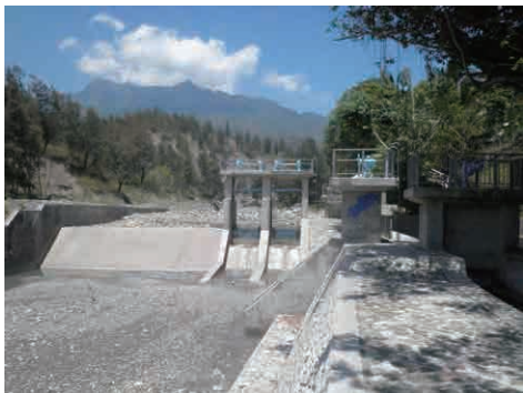
取水工全景 (左岸下流から上流方向、写真中央は土砂吐水路)
