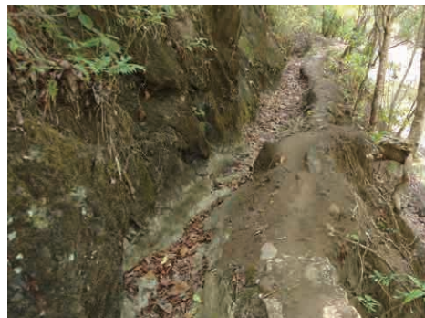
ダルダウ灌漑地区 現況水路 (写真は岩を掘削して建設した水路である。拡幅により水路の通水能力を大きくすることによる作付面積拡大を計画する)
