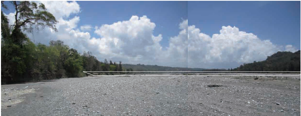
ベイカラ灌漑地区取水工予定地点（右岸下流から上流を見る） 河床堆積物は比較的粒径が小さく、概ね 20cm 以下である。
