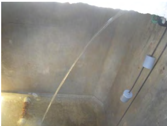
中継タンクへの吐出状況
