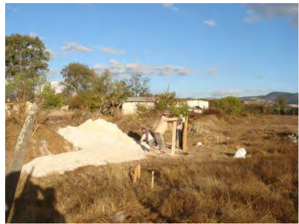
凝灰質砂岩土壌で容易に井戸を掘削している。
