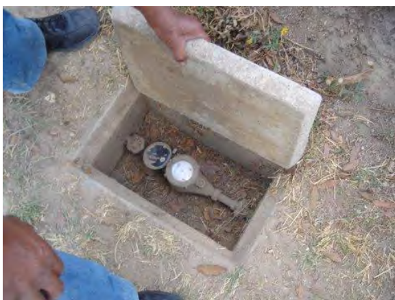
各戸の入口に設置されている量水計
