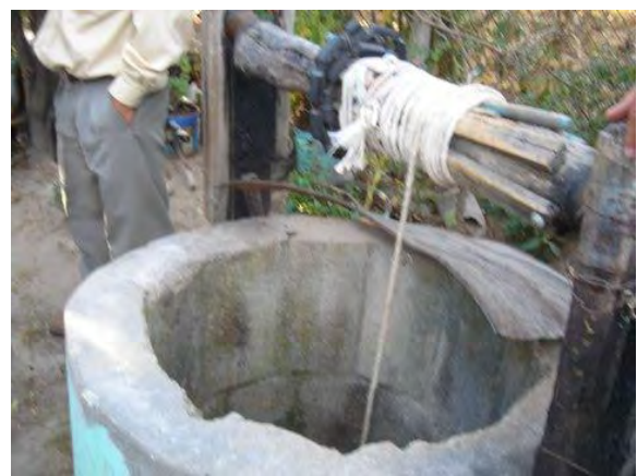
掘り抜き井戸の水深は約 13m
