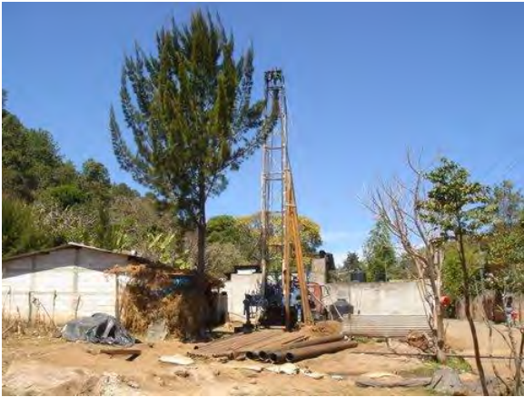
井戸掘削地点 右側に三相送電線が走っている。
