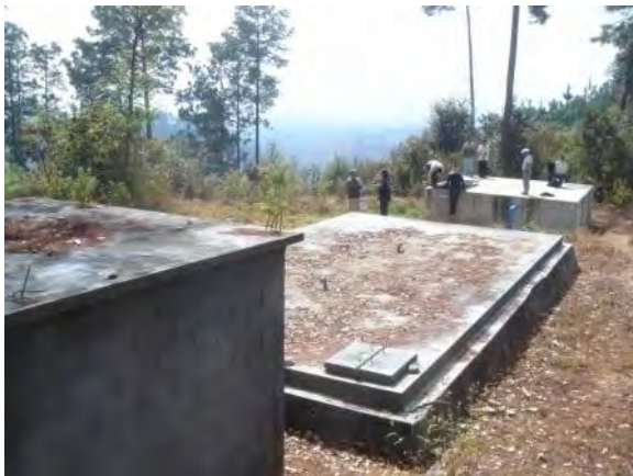
手前が既存の貯水タンク、後方がプロジェクトで整備された貯水タンク
