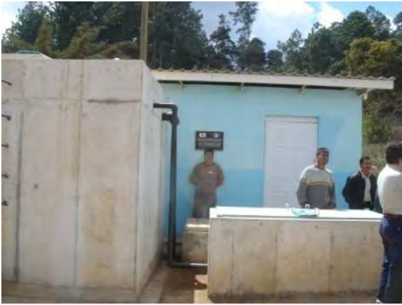
手前左中継タンク、右井戸ポンプ、 後方にポンプ小屋
