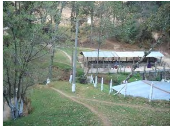
水槽（水場）は洗濯ができる施設付きとなっ ている。
