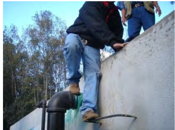
貯水タンクの階段部
