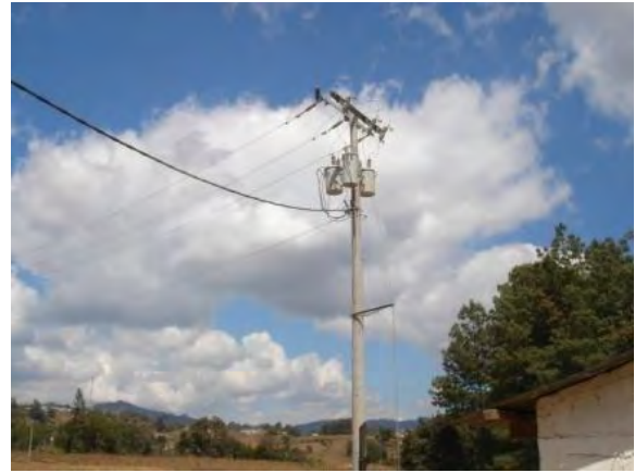
送電線電柱とトランス
