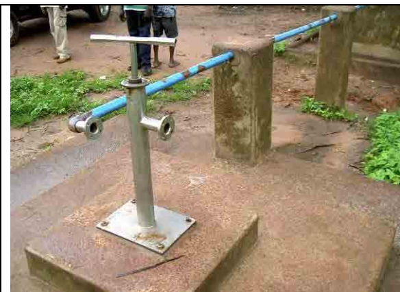
Bor 村人力ポンプ（その1） 人力ポンプは HYDRO VERGNET の 3C 型、1ヶ月前から故障中（部品調達に時間を要している）
