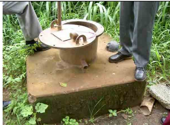
1960年代に建設された深井戸 深度 100m 以上、10 インチ径。鉄の濃度が高いため使用していない。
