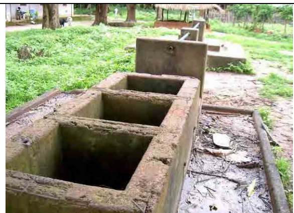
左の写真の人力ポンプの洗濯場 ゴミが散乱しており、洗濯場は長期間使われていないものと思われる。
