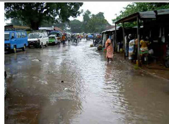
降雨時の道路（Mansoa 町） スコールがあると道路の排水が追い付かない。
