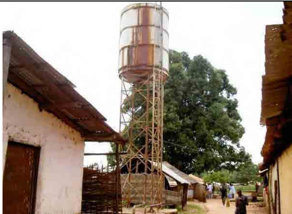
市街地の中心地区にある高架水槽
