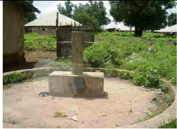
公共水栓 公共水栓が 19 箇所あるが使っておらず、133 件の各戸接続で給水している
