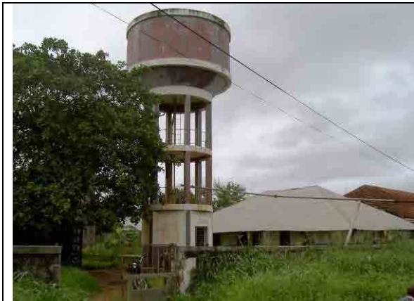
1960年代に建設された高架水槽 鉄筋コンクリート製、老朽化のため使用していない。
