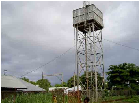
1994年オランダSNVによる井戸と高架水槽
