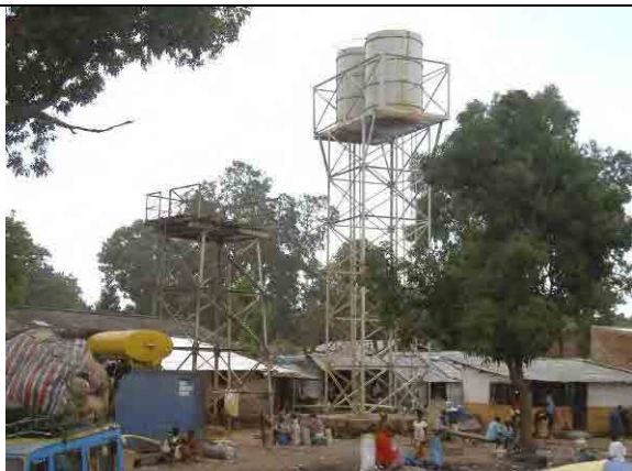
放棄された古い高架水槽
