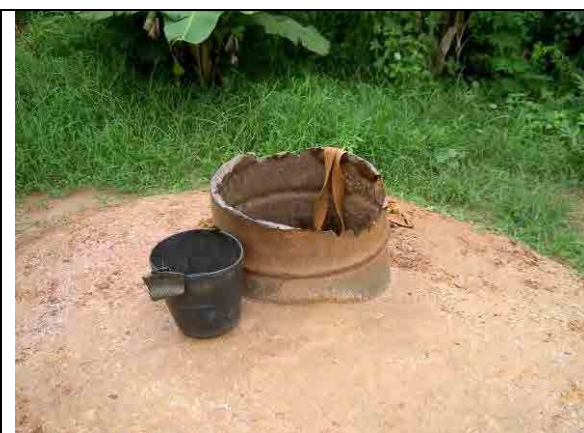
Blom 村の伝統的浅井戸 手掘りの浅井戸で、口元付近のみ崩れないようにドラム缶で保護してある。水位は約 12m。
