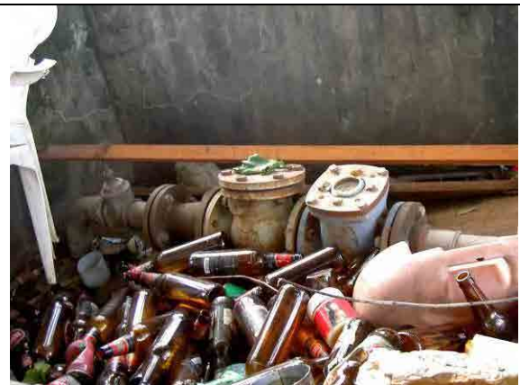
1985年以前の給水施設の水源深井戸
