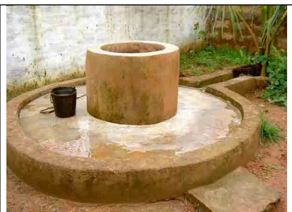
Blom 村の近代的浅井戸 コンクリート保護されているが、硬質のラテライト層は裸孔のまま。水位は約 15m。
