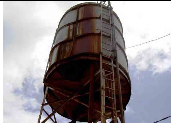
高架水槽の近景
