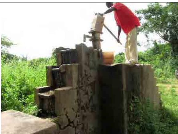
ニャクラ郡 Caramoco 村の鉄除去装置 1997年 UNDP 建設。INKAR 製ハンドポンプは稼働している。鉄除去装置は使っていない。
