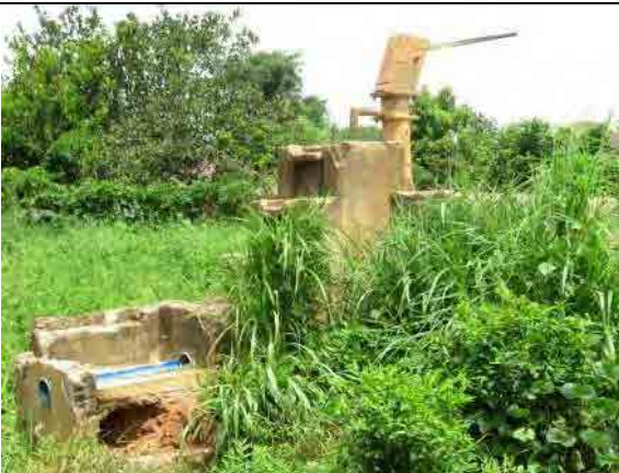
ニャクラ郡 Cuntenga 村の鉄除去装置 UNDP 建設。初期の井戸には鉄除去装置はなかったが、2年後に設置された。故障放置。砂はない。
