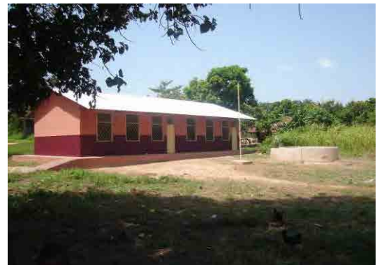
"日本の支援により UNICEF が建設した学校。手前にあるのが、学校用の深井戸 (コンクリートの塀付) (Nova Visela-Bissora)。"
