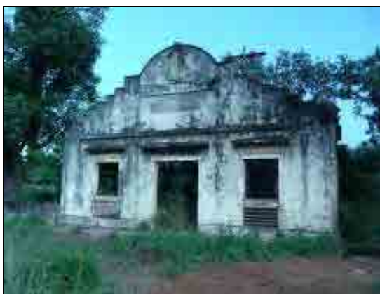
マンソア市国営電力公社跡（1952年）
