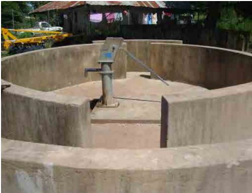
既存水源： 近年建設されている施設はこのよう なブロック塀が標準設置されている (Mansoa 町)
