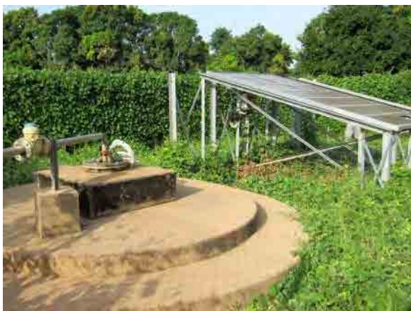
バファタ州 Fajonquito 村の太陽光揚水システム PRS フェーズ 1 で建設されフェーズ 2 で 2008 年にリハビリされた。揚水量は 23 m 3 /day。直流式。
