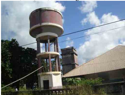
Mansoa 町のポルトガル当地時代に建設された配水池。改修は困難なため、新設が望ましい。
