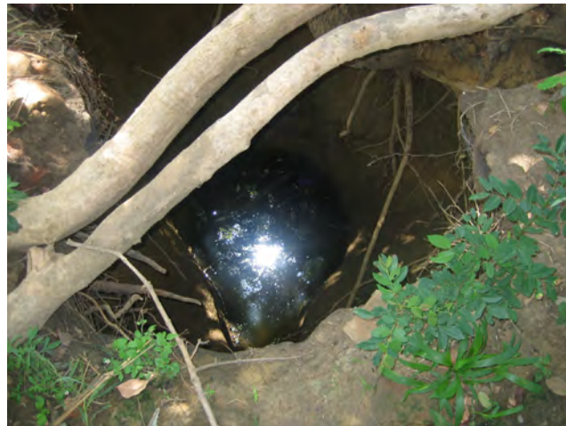
写真2 農家の手堀井戸 多くの農家は自ら手で掘った井戸から生活用水を得ている。
