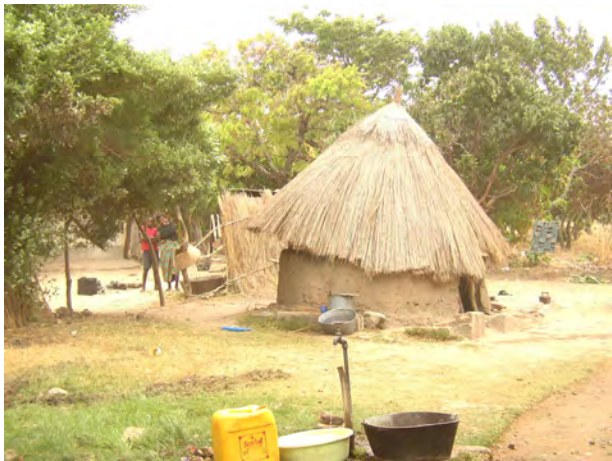
写真1 農村部の家屋 多くの家屋は土レンガで作られ、トウモロコシなどの残渣を屋根に利用している。
