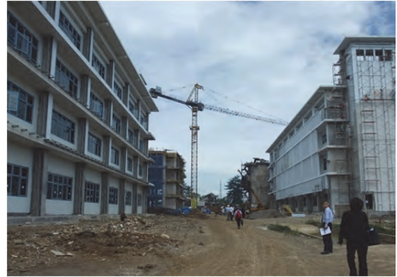
新工学部建設中キャンパス（ゴア県）
