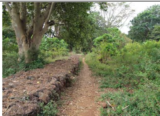
湧泉（写真左側）を、河川氾濫水から保護するため設置された蛇籠式の堤防。
