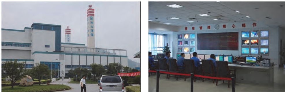
図5-5 蘇州市における都市ごみ焼却発電施設（写真）
