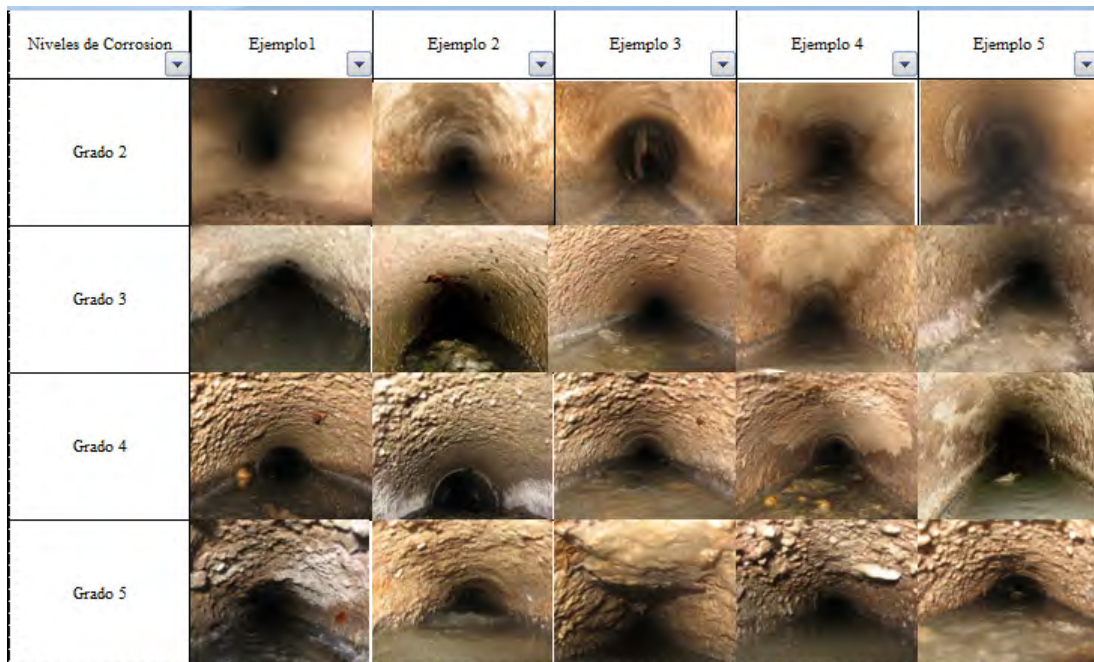
Foto N° 2.5.9-1: Condición de corrosión de tuberías por grado
