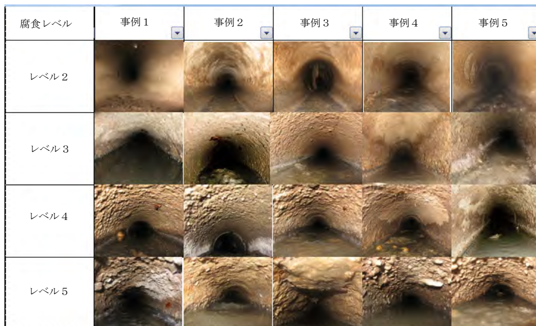
写真 2.5.9-1: レベル別の管腐食状況
