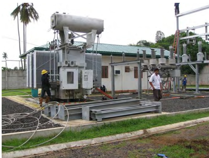
図 6 - 5 建設中の新しい変電所
