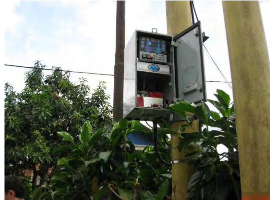
図 2-13 リクローザ用コントロール装置
