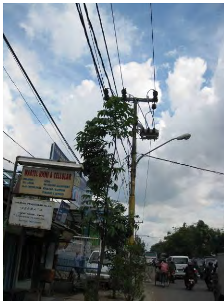
図 2-14 柱上負荷開閉器 (LBS)
