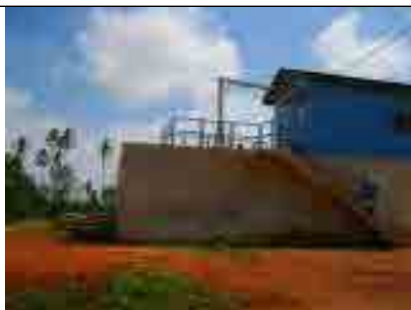
無償資金協力（第 2 期）で建設したドーレ配水池。西部都市地域北部に配水している。
