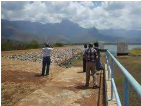
モロゴロ市街への給水のための水源となるミンブダム。堤長は1.5km、貯水量は12,000,000m 3 。
