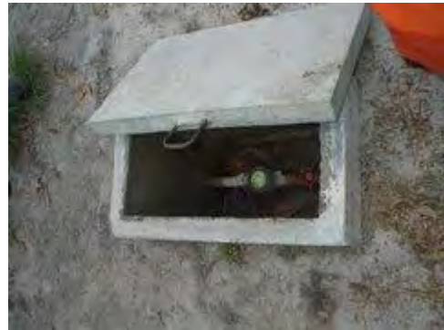
キツンダ・キヴレ村の給水ポイントのメーターボックス。12月11日に訪問した際には少量の漏水が認められた。
