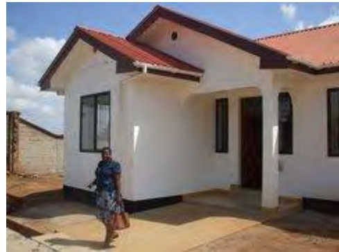
モロゴロ州モロゴロ市水技師事務所。WSDPの資金で新設されている。管内の水源は3基のダムと2本の深井戸である。
