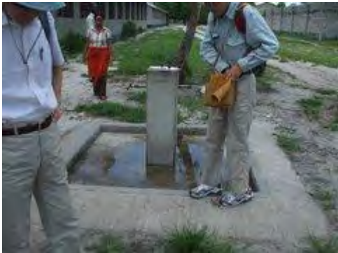
キツンダ・キヴレ村(ダルエスサラーム州)の給水ポイントの一つ。小・中学校の敷地に設置されている。
