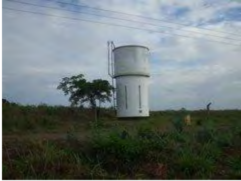
モロゴロ県ムカムバラニ村の給水タンク。取水口は34km上流にあり、このタンクから12ヶ所の給水ポイントに配水している。
