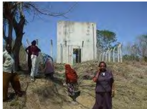
JICAによりリンディ県マダングワ村に設置された給水タンク。水源の深井戸は谷沿いにあり、そこからポンプで送られている。
