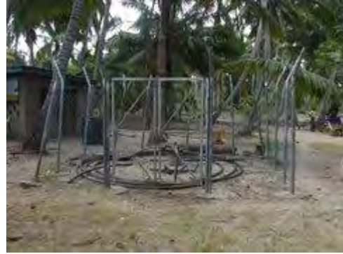
2000年にDDCAにより掘削された深井戸。5ヶ所の給水ポイントが設置されているが、さらに10ヶ所の給水ポイントが必要とされている。
