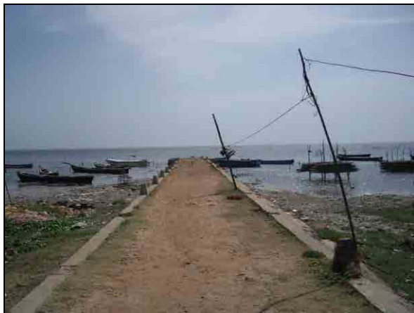
Jetty Renovation (Before)
