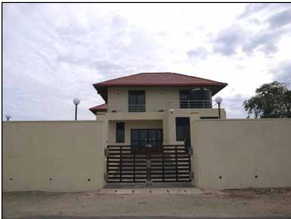
FC-6 水産学校再建(施設改修)
