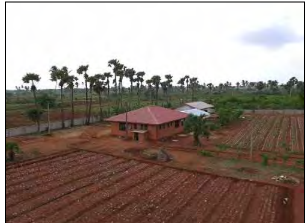
AC-5 ココナッツ苗畑復旧(施設改修)
