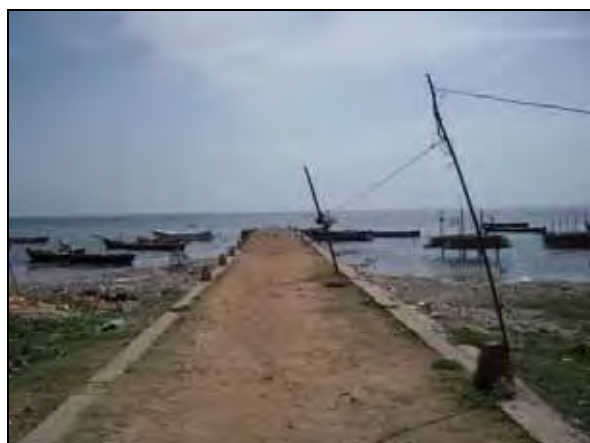
緊急リハビリ事業(QIPP) 棧橋改修 ナワントゥライ棧橋 (改修前)
