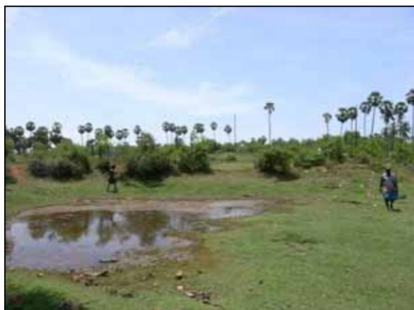
緊急リハビリ事業(QIPP) ため池改修 ウチャライ・クラム (改修前)
