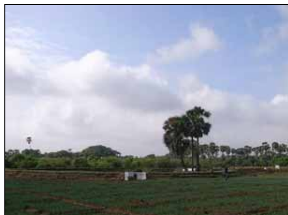
緊急リハビリ事業(QIPP) ため池改修 ウチャライ・クラム (改修後)
