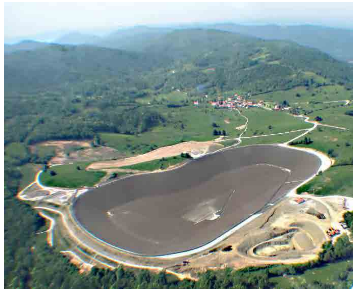
図 3.21 Avce 揚水発電所上部調整池
