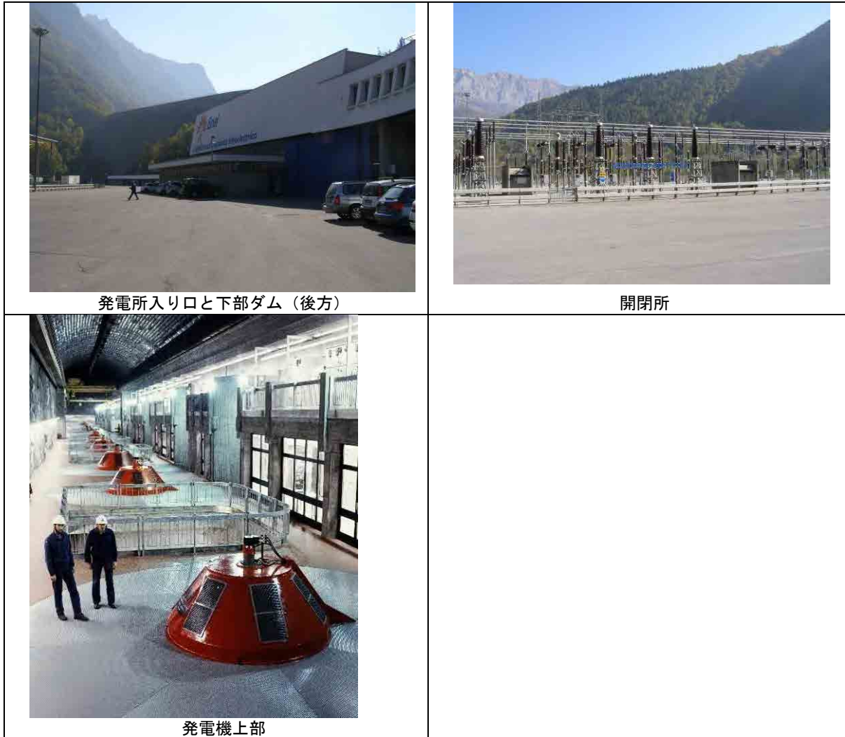
図 3.20 Entracque 揚水発電所（写真）
