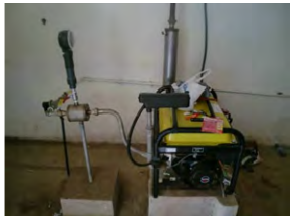
燃料供給系を改造した発電機
